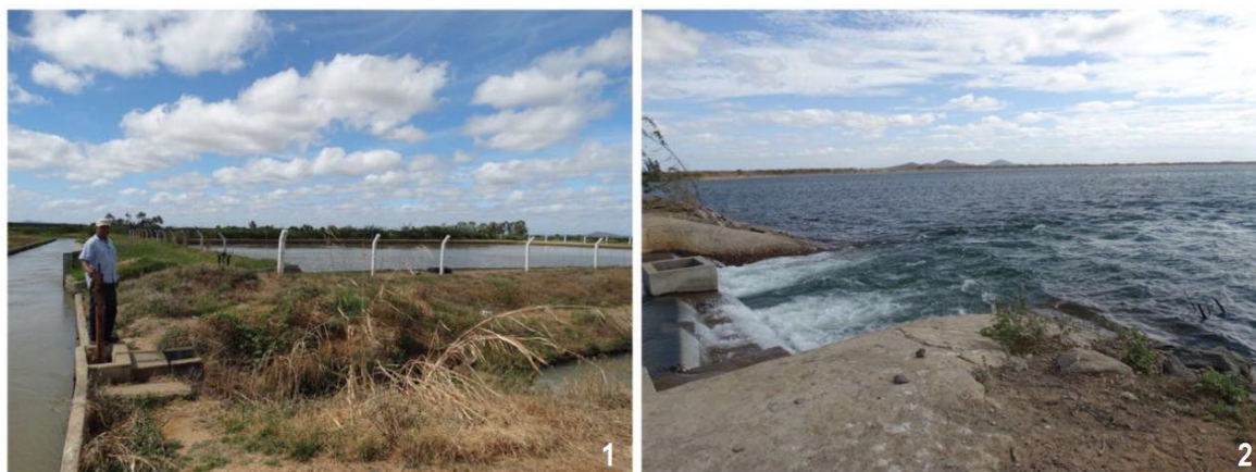
FIGURA 4.2 – Reservatórios internos dos perímetros do Polo Petrolina-PE/Juazeiro-BA. 2016.
