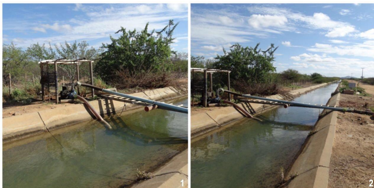
FIGURA 4.5 – Estruturas de captação precárias de ocupações irregulares no Projeto Salitre, em Juazeiro (BA). 2016.
