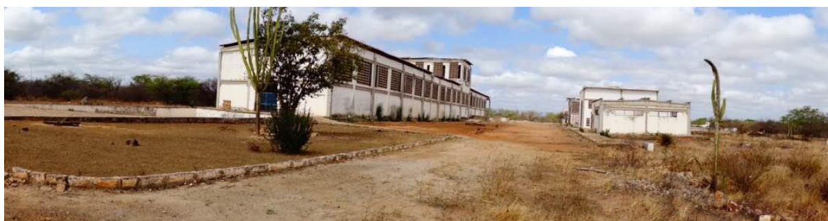
FIGURA Nº 1.2 - Instalações abandonadas de antiga fábrica de tomate PALMEIRON (porte médio), no Projeto Tourão, em Juazeiro (BA), agosto de 2016. Foto do autor.
