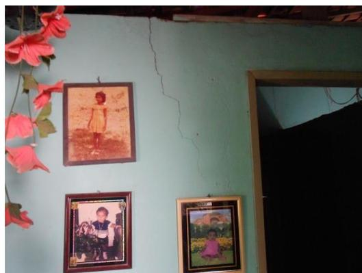
Figura 65 - Rachaduras nas casas por vibrações de caminhões que passam pelo caminho do engenho Tiriri. Fonte: Solá Pérez, 2013.
