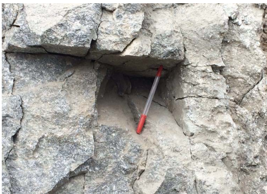
Figura 35. Fratura na Face Livre A1.
