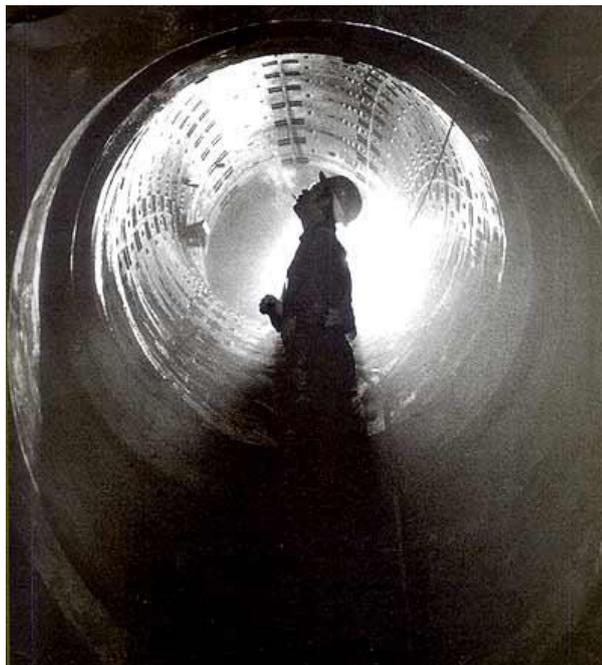
Fig. 23 – Finalizando a instalação do sistema de circulação do ar. Estes túneis pequenos são cavados manualmente e juntam-se aos dois túneis principais para permitir a passagem livre do ar entre eles. Calais, França, 1990. Sem título, da série Eurotúnel, França e Inglaterra (Sebastião Salgado, 1993)
