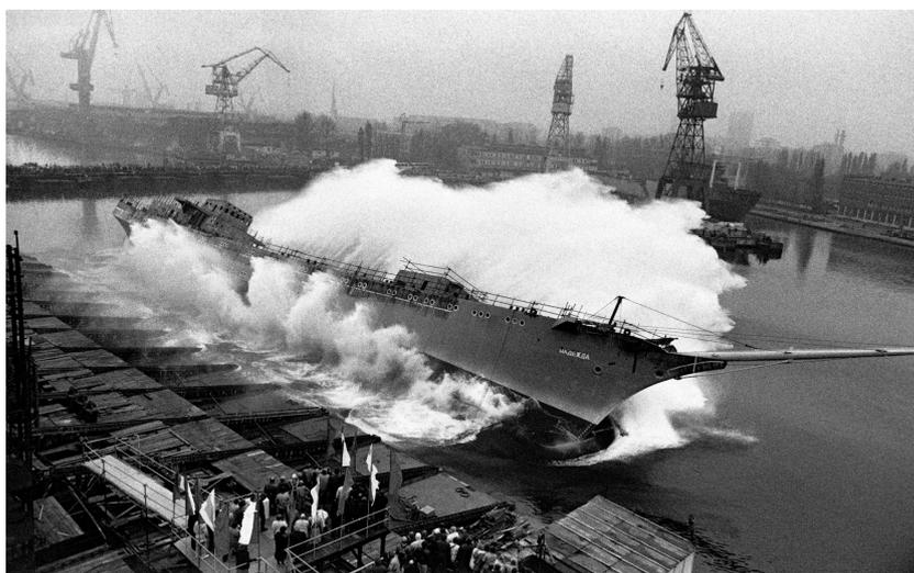
Fig. 30 - ÷Um navio é lançado lateralmente à água; a pressão da água o obrigará a tomar a posição vertical. Após muitos meses nasceu agora um navio: quando seu interior estiver terminado, ele se desligará então das centenas de homens que ajudaram a construí-lo. Gdansk, Polônia, 1990. Sem título, da série Estaleiros, Polônia e França (Sebastião Salgado, 1993)
