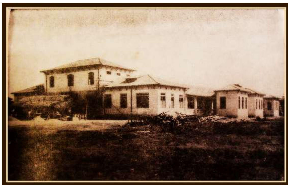
IMAGEM 09- Hospital-Colônia Juliano Moreira em construção, 1923.
