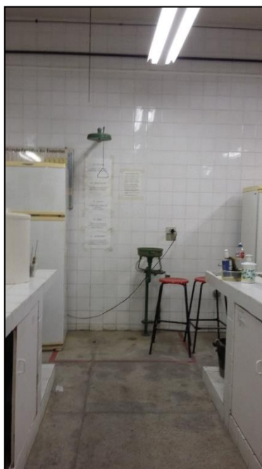
Figura 5 – Piso e parede dos LEQs/DQF
