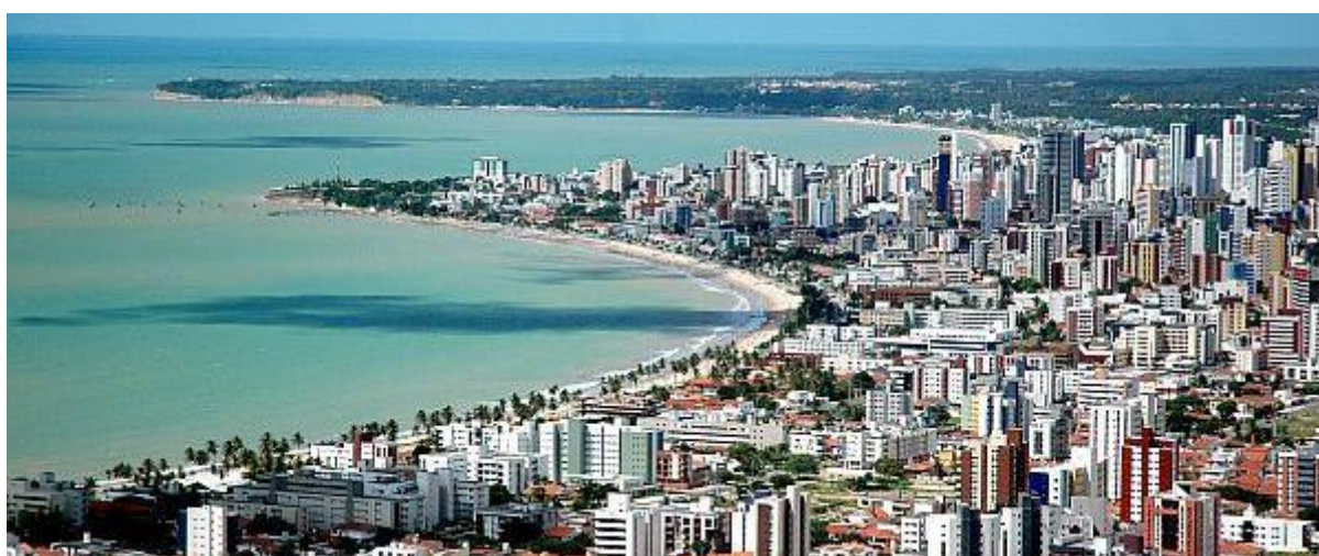
Figura 05 —Verticalização construtiva da área urbana em João Pessoa/PB
