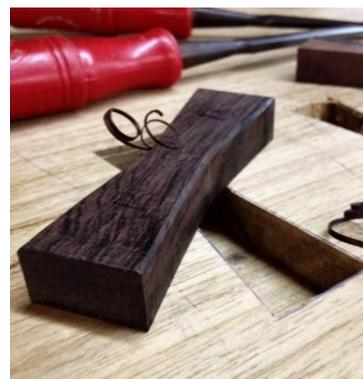
Figura 144: Detalhe do encaixe da borboleta
