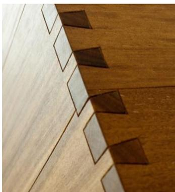
Figura 143: Detalhe do encaixe rabo de andorinha
