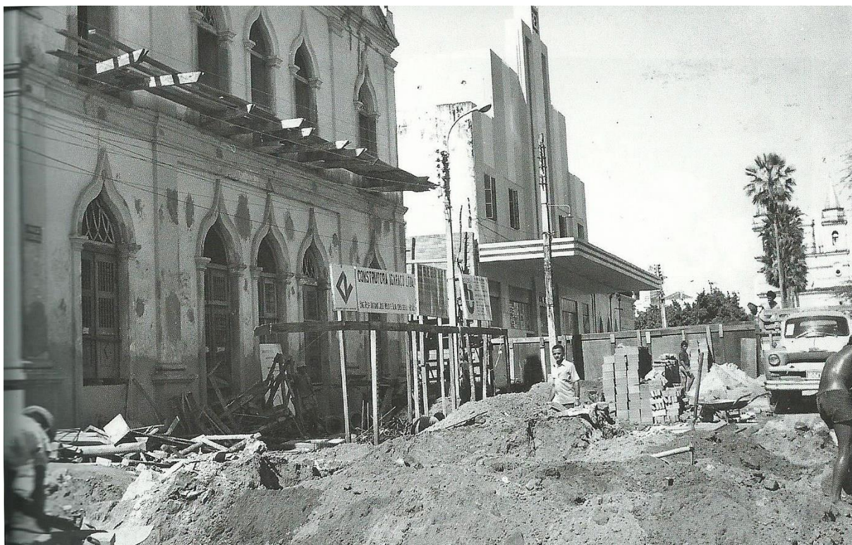
Figura 25: Obras de reforma do Theatro 4 de Setembro, em 1975.
