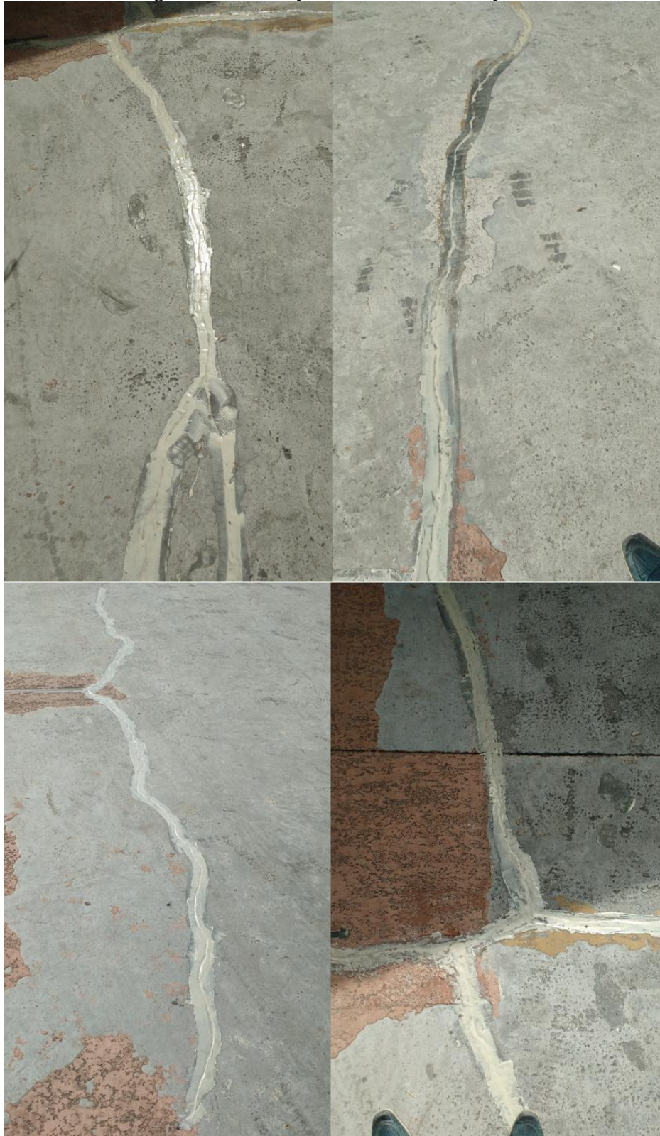
Figura 43 – Fissuração tratada com resina epóxi.
