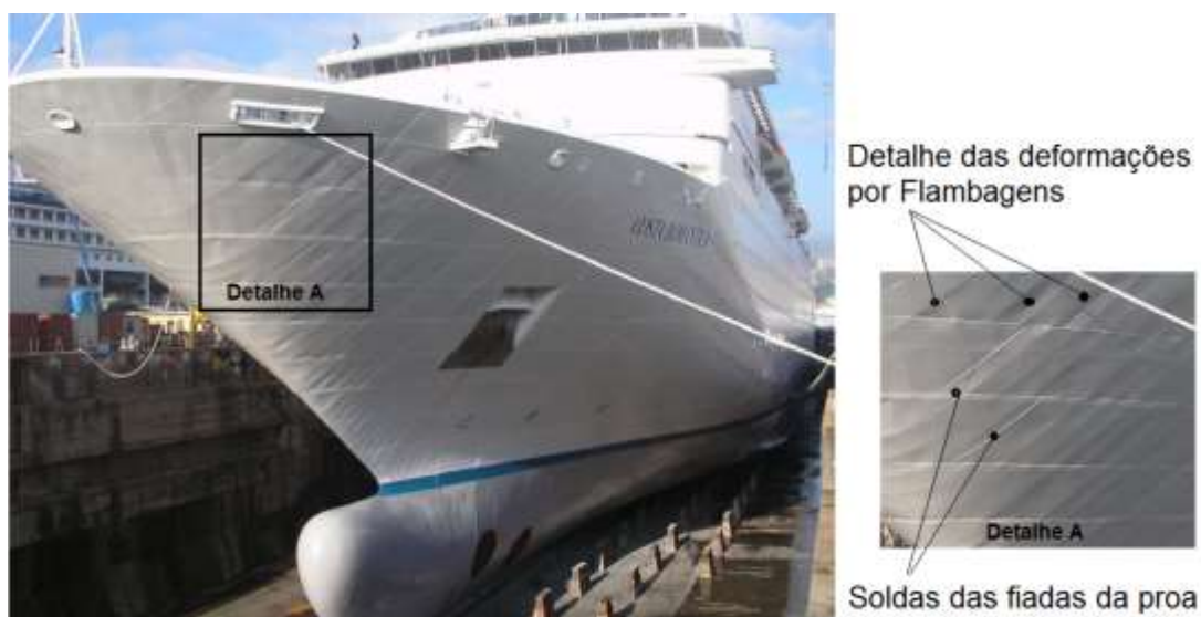
Figura 4- Proa de um navio com deformações devido a soldagem
