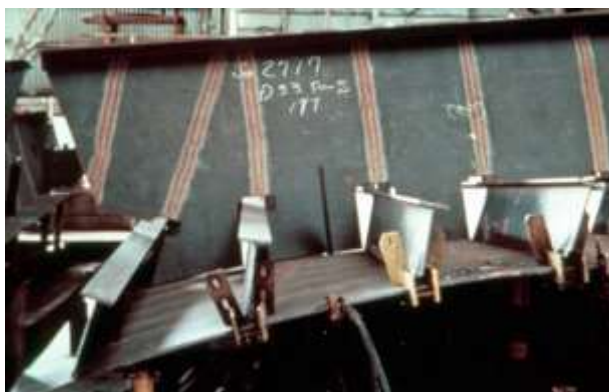
Figura 2- Montagem de dois painéis para compor um bloco.
