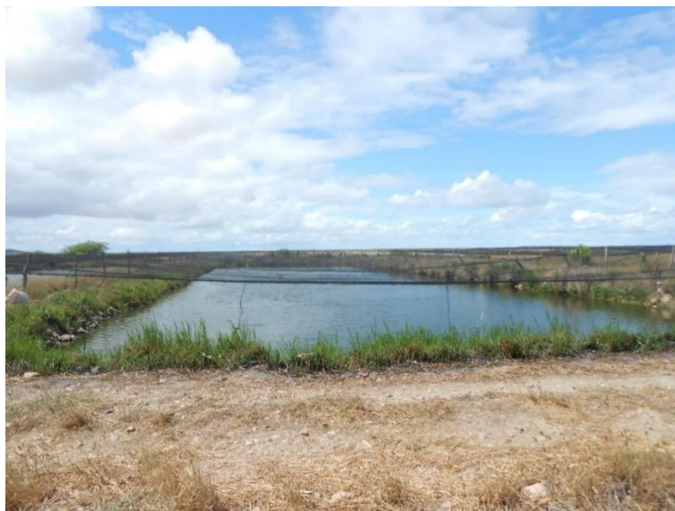
Figura 5 – Tanque escavado para cultivo de juvenis de tilápia do Nilo, em Itacuruba, semiárido pernambucano.
