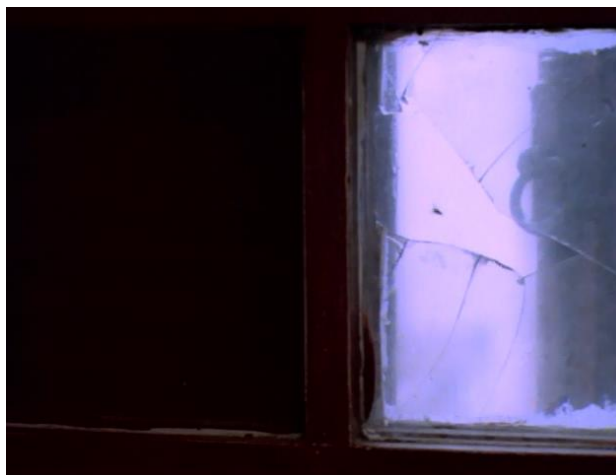
FIGURA 3 – As moscas no vidro quebrado da janela do quarto.
