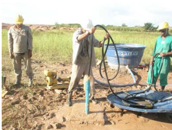
Figura36 –Fase de limpeza nos poços de monitoramento.
