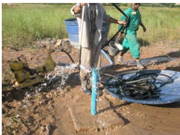
Figura36 –Fase de limpeza nos poços de monitoramento.
