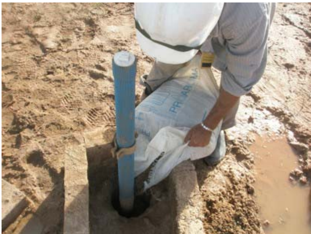
Figura 35 - Colocação do pré-filtro.
