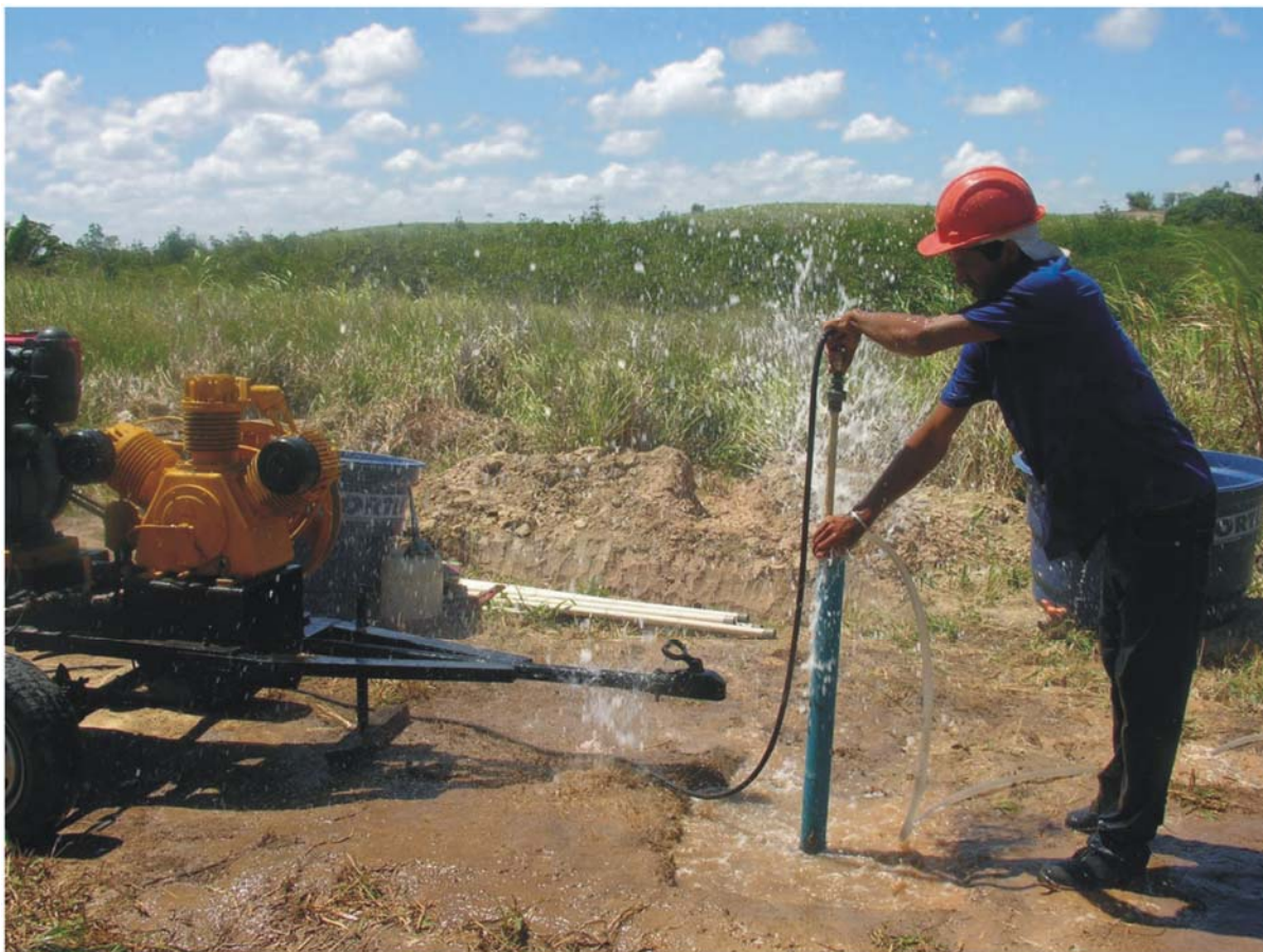
Figura 37 - Desenvolvimento do poço pelo método air-lift .
