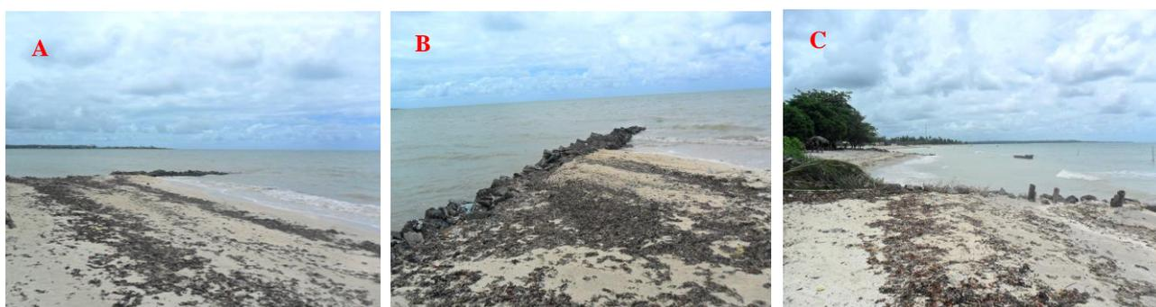
Fonte: A autora (2016). Em A, podemos ver o acúmulo de sedimentos à barlamar da estrutura; em B, podemos ver a espia com maiores detalhes; e em C podemos observar a reentrância e erosão à sotamar da estrutura, resultado de mudanças na dinâmica hidrológica e sedimentar local, provocadas pela construção das espias.
