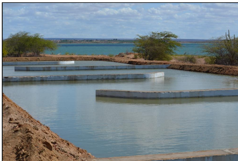
Figura 22 - Vista superior da wetland construída para tratamento de efluente de piscicultura
