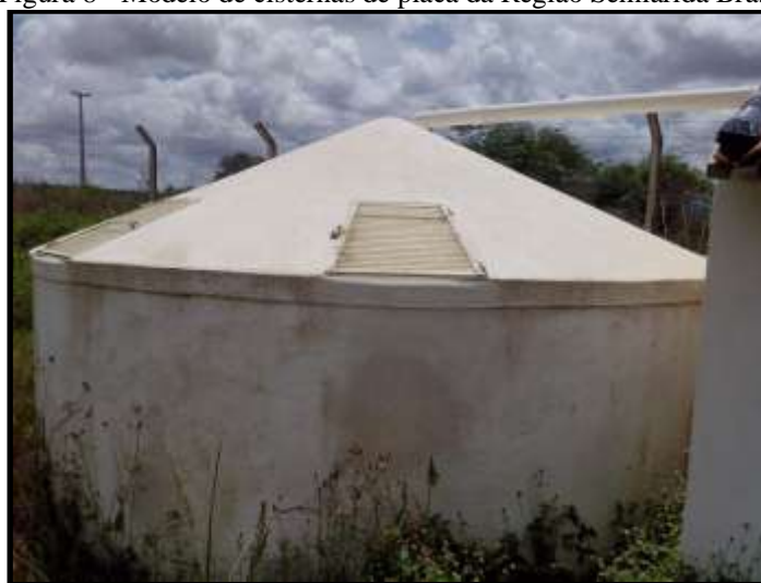
Figura 8 - Modelo de cisternas de placa da Região Semiárida Brasileira.
