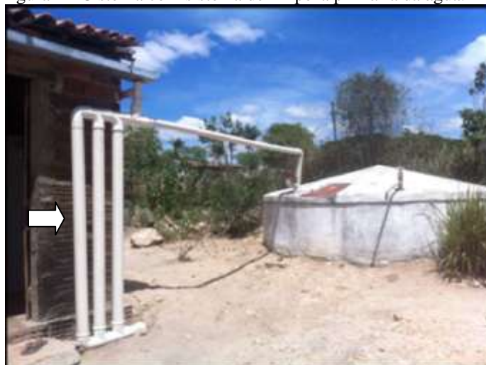
Figura 2 - Cisterna com sistema de limpeza primária da água.
