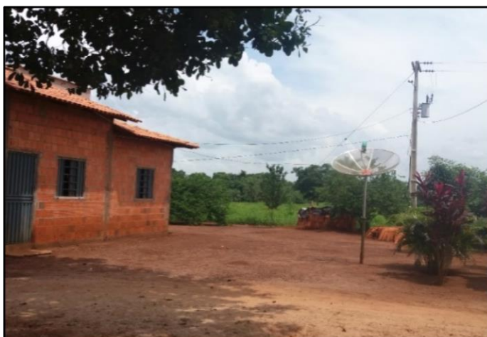
Figura 45 - Antena de TV, poste de energia elétrica e casa construída em uma propriedade sertaneja
