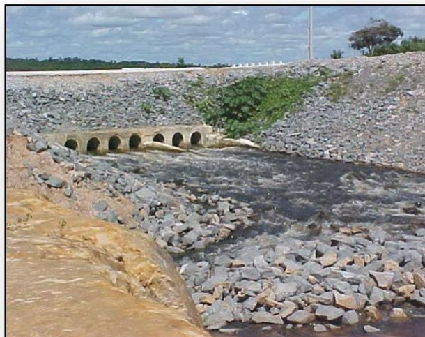
Figura 45 – Vertedouro criado em 2002 para manter regularizado o nível da água na lagoa do Catú. Foto: da autora, 2002.
