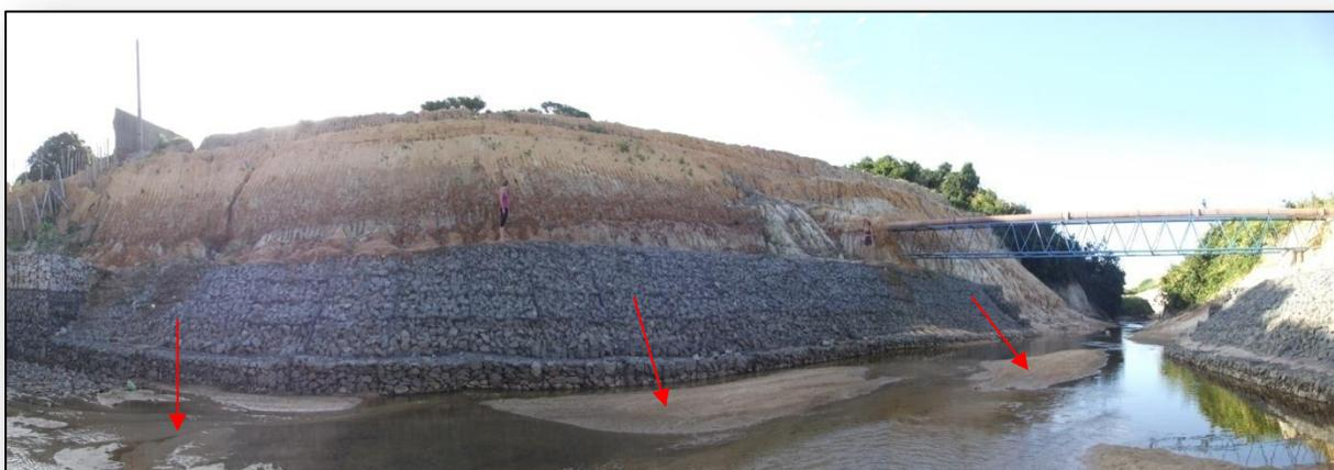
Figura 56 – Assoreamento do leito com material arenoso no leito que desce dos taludes. Foto da autora, 2011.
