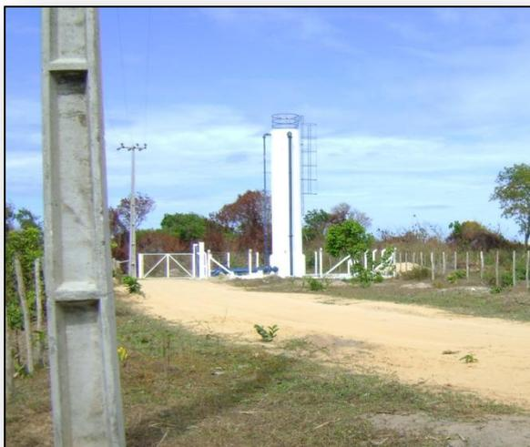
Figura 41 – Estação elevatória de água próxima à localidade de Engenho Velho construída para subsidiar o empreendimento. Foto: da autora, 2010.
