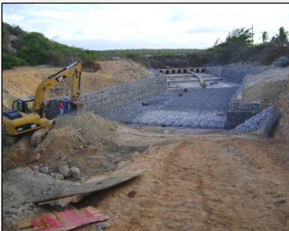
Figura 47 – Detalhe das obras de recuperação do vertedouro e leito do rio Catú em dezembro/2010. Foto: da autora, 2010.
