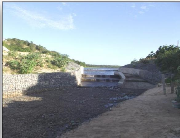
Figura 48 – Depois de finalizada a obra, o leito recebeu estruturas rochosas assentadas em malha de arame para evitar a erosão das rochas. Foto: da autora, 2011.
