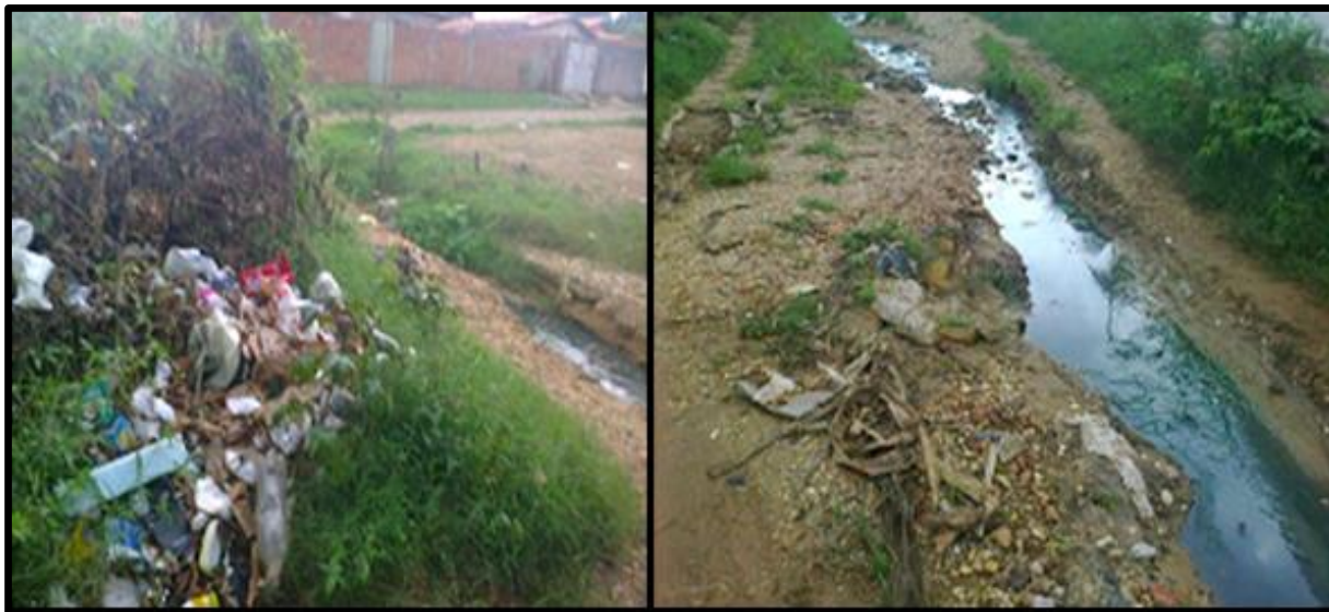
Fotografia 8 – Imagens de ruas sem pavimentação, destacando a presença de esgotos a céu aberto, Bairro Santo Antônio, Teresina, PI
