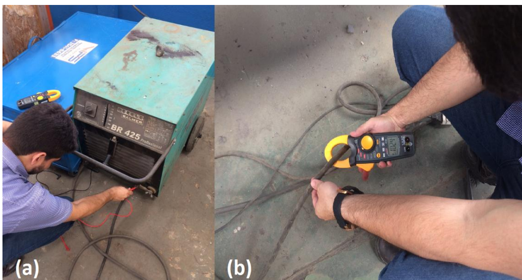
Figura 21 – Monitoramento dos parâmetros de soldagem na execução (a) e (b).
