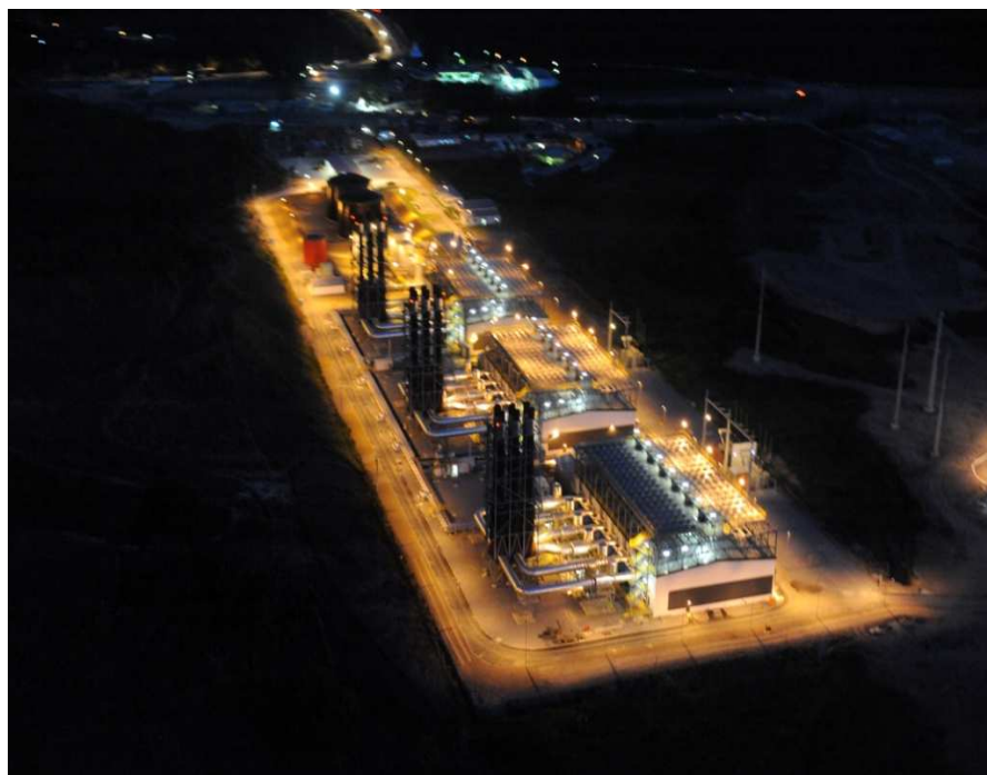
Figura 40 - Usina termelétrica UTE SUAPE II
