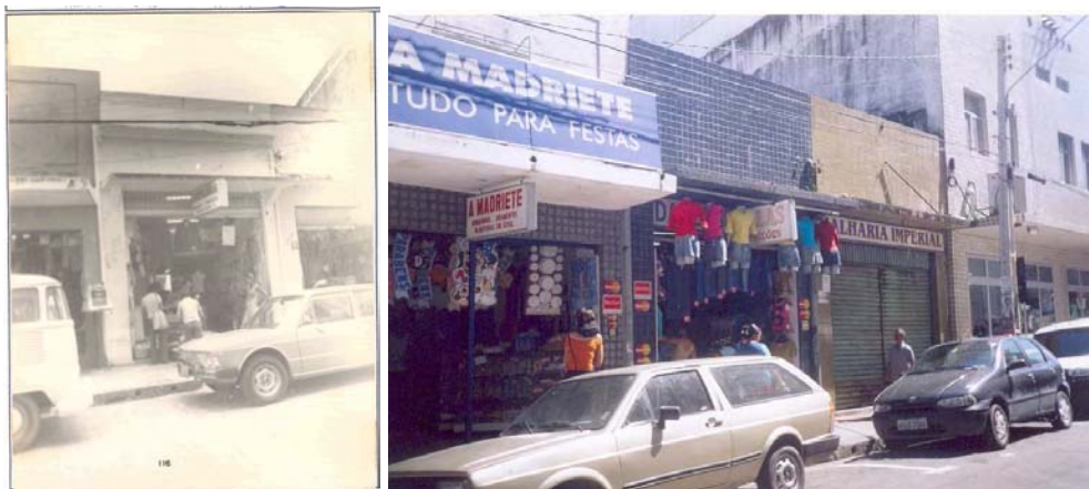
Figura 2/83 e 2/84. Edifício da Rua das Calçadas n°116, em 1970 e 2005. Retirada das cornijas da platibanda.
