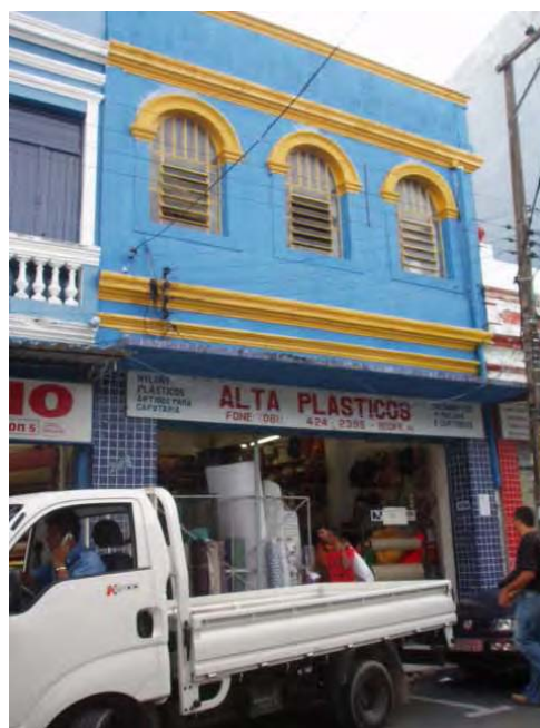
Figuras 2/52 e 2/53. Edifício da Rua Direita nº 288, em 1970 e em 2006. Alargamento de porta e construção de marquise.
