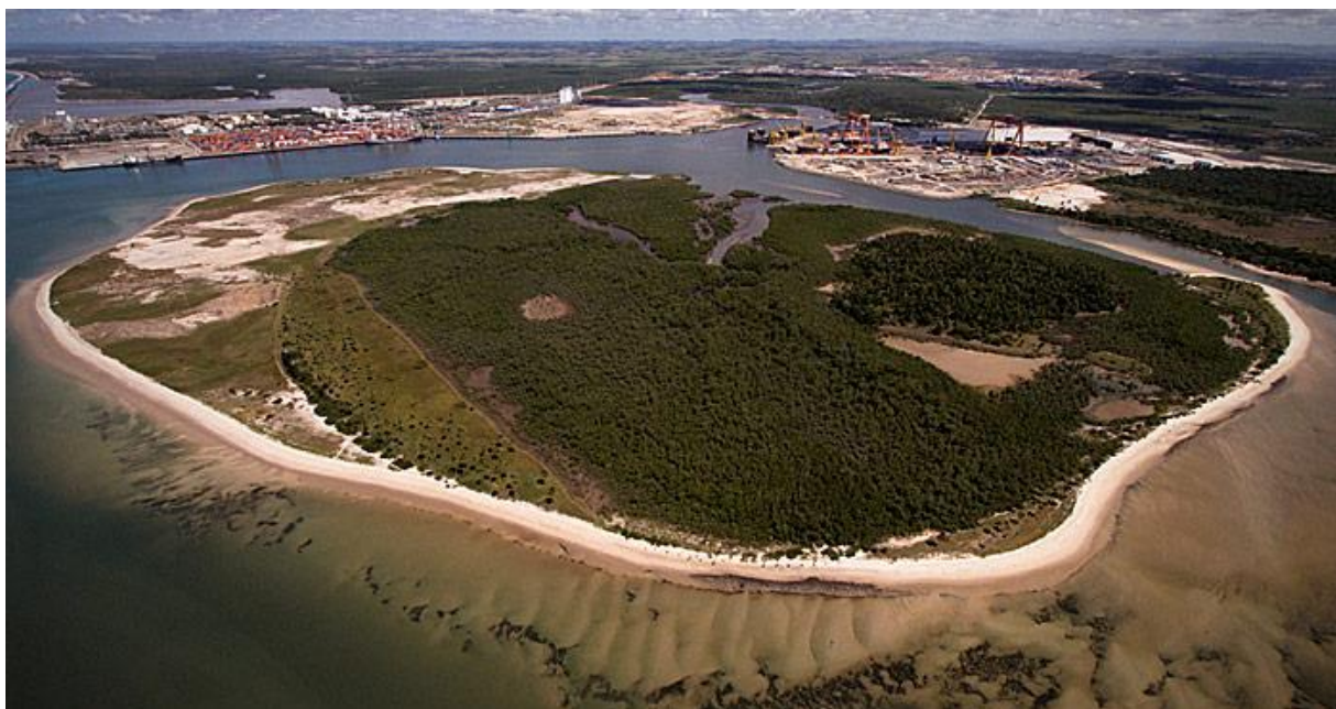
Figura 12 – Imagem aérea da Ilha de Cocaia, local onde será implantado o terminal de Granéis minerais no porto de Suape
