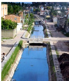
Figura 20. Saneamento básico: Revestimento do Canal dos Guarulhos – Jardim São Paulo
