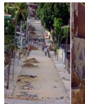
Figura 26. Pavimentação, drenagem, contenção e escadaria
