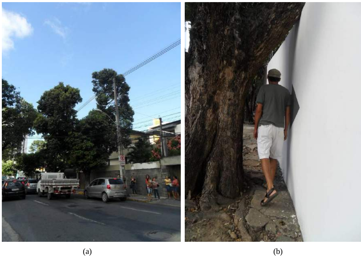
Figura 122 – Vistas de indivíduos arbóreos no bairro do Espinheiro. Conflitos existentes entre a arborização e a rede de energia elétrica, à pavimentação e á acessibilidade.
