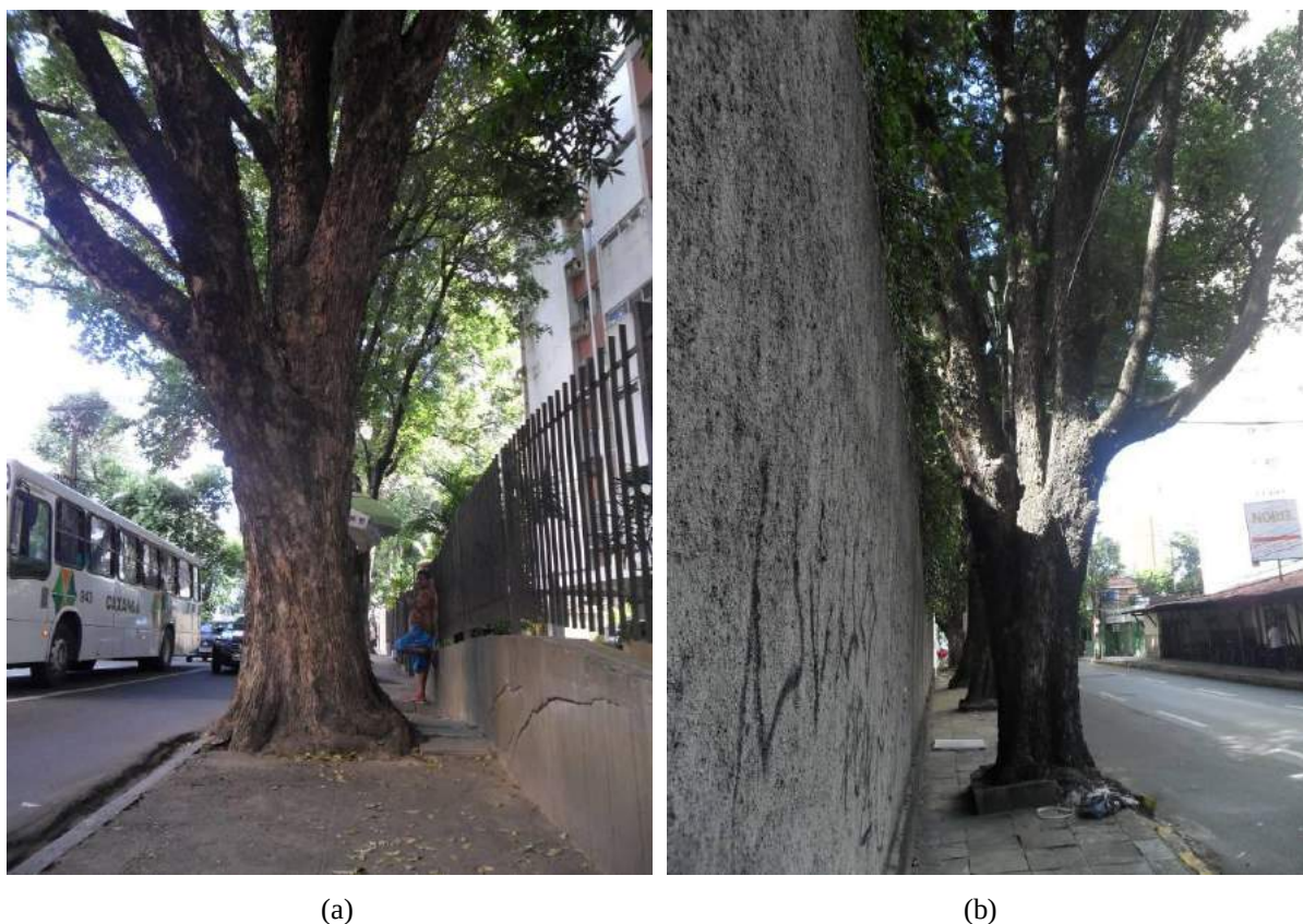
Figura 121 – Vistas de indivíduos arbóreos no bairro do Espinheiro. Relação desproporcional entre o porte dos indivíduos e as calçadas.
