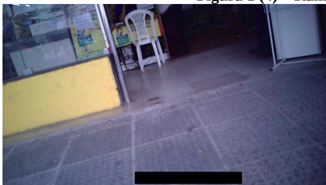
Figura 1 (4) – Rampa de Acesso
