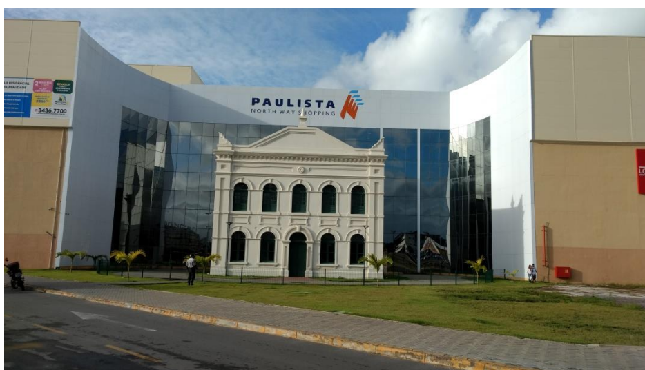
Fotografia 17 – Fachada do Paulista Northway Shopping, 2017. Fonte: Foto da autora.
