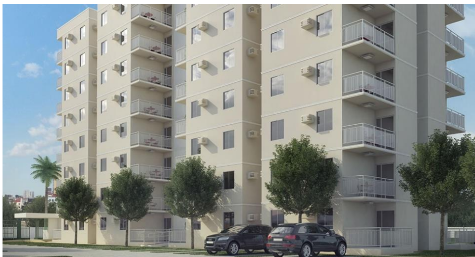
Fotografia 19 – Aurora do Paulista. Simulação da aparência final do condomínio ainda em construção, s/d. Fonte: Construtora Carrilho 447 .
