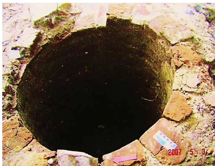
Figura 4 - Estrutura de tijolos vermelhos do poço no. 5, Rua da Moeda.
