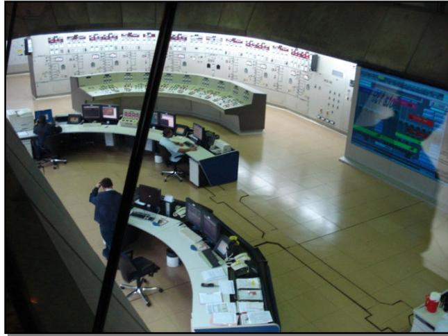
Figura 3.10 – Sala de controle com tipos mais tradicionais de displays: mostradores analógicos, indicadores luminosos e digitais, video wall.
