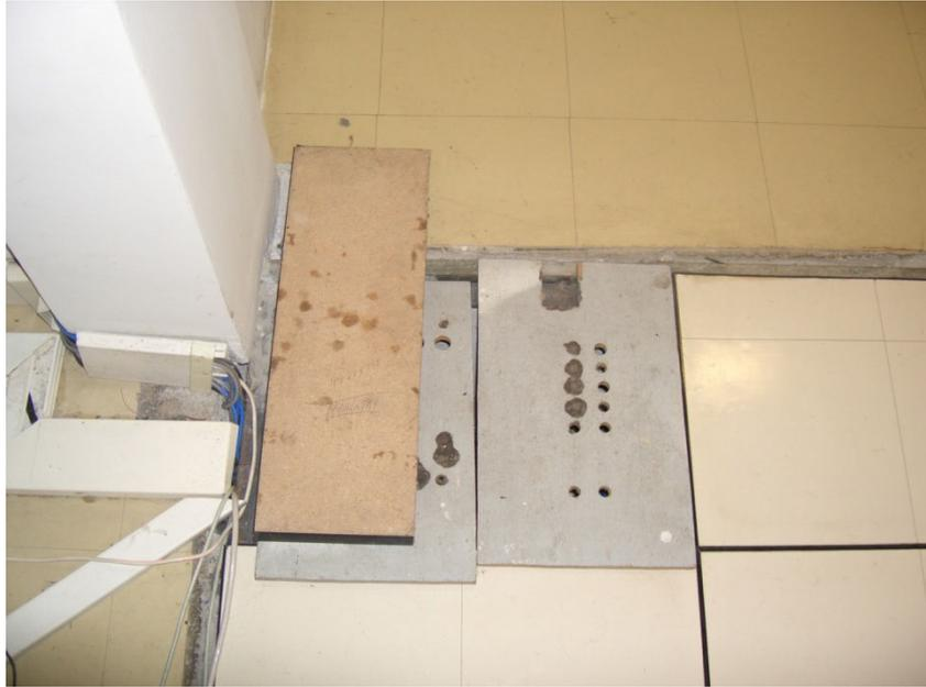
Figura 5.18 – Tampa de inspeção do piso falso por onde chegam os cabeios de alimentação dos equipamentos.
