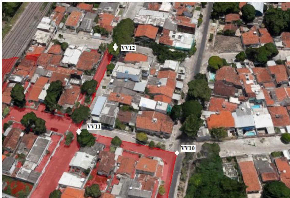
Figura 95 – O cruzamento Dr. Luiz Correia de Oliveira e rua Barão de Tefé, cruzamento da rua Barão de Tefé com a rua Aranã e rua Aranã com a rua Adalto C. leal.
