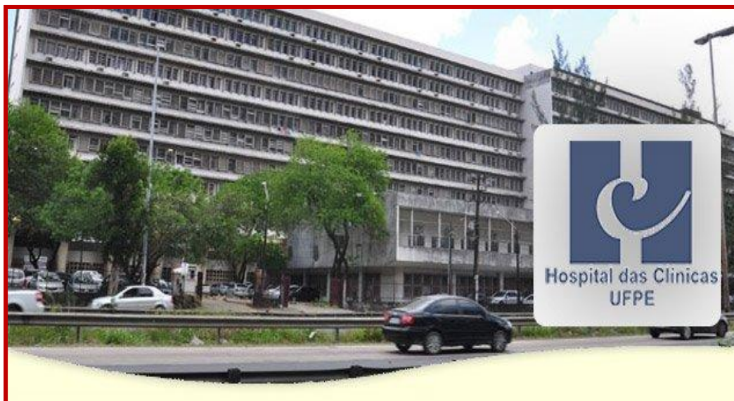
Figura 6 - Vista Frontal do Hospital das Clínicas da UFPE.
