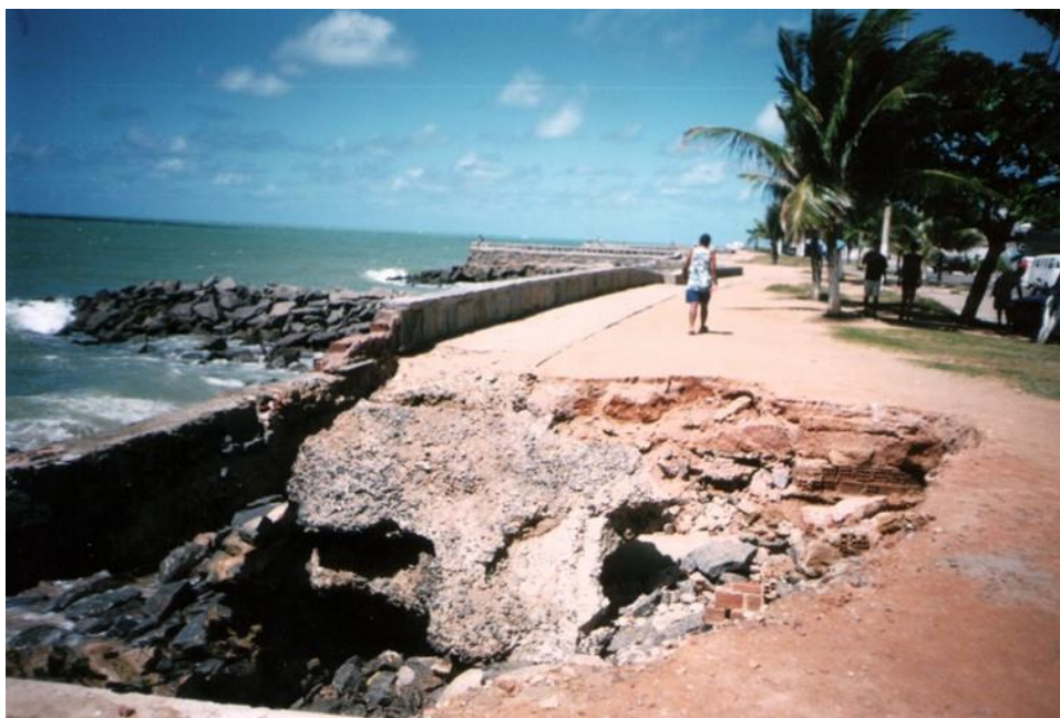
Figura 13 – Deficiências nas estruturas de defesa costeira provocaram desmoronamentos nas áreas urbanizadas da orla de Bairro Novo (2003).
