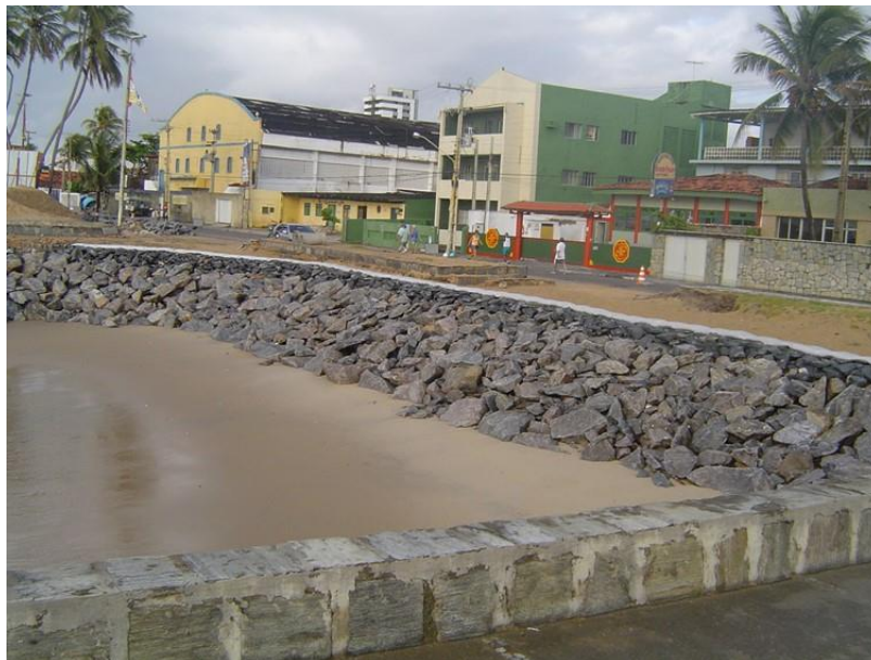
Figura 17 – Enrocamento implantado em substituição ao enrocamento de pedras jogadas, antes existentes na praia de Bairro Novo, Olinda-PE.
