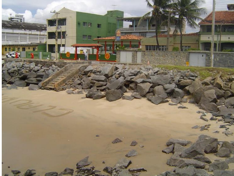
Figura 16 – Enrocamento de pedras jogadas na praia de Bairro Novo, Olinda-PE.
