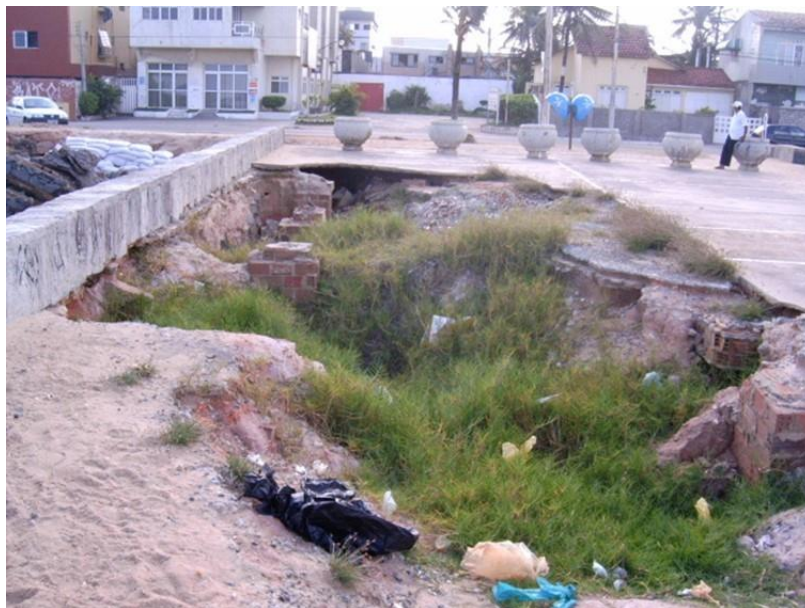
Figura 15 – Espigões atingidos por abatimentos por toda a extensão da orla de Bairro Novo.
