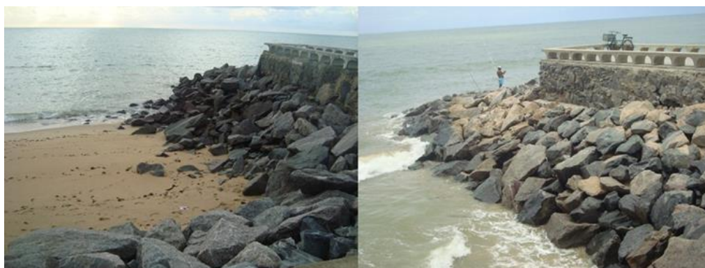
Figura 22 – Obra de recomposição de taludes dos espigões da praia de Bairro Novo, Olinda-PE.
