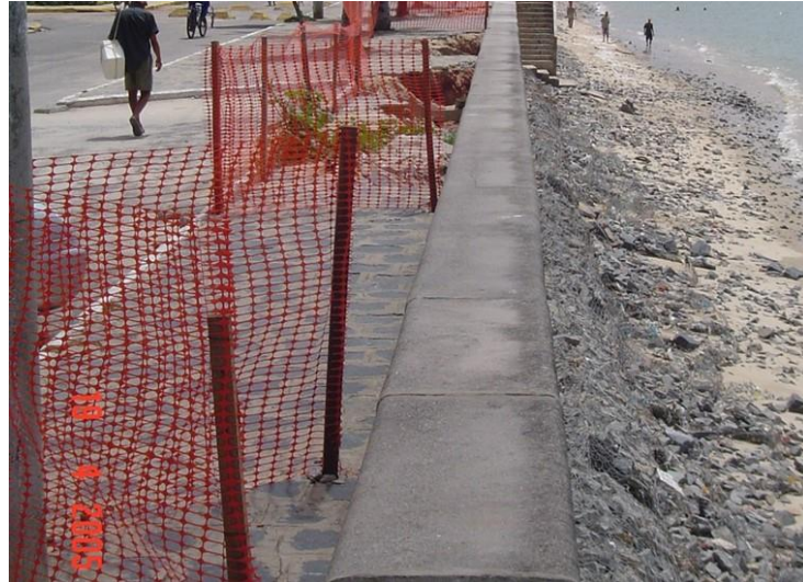
Figura 23 – Gabião como defesa costeira, não suportou e rompeu, espalhando pedras por toda praia.
