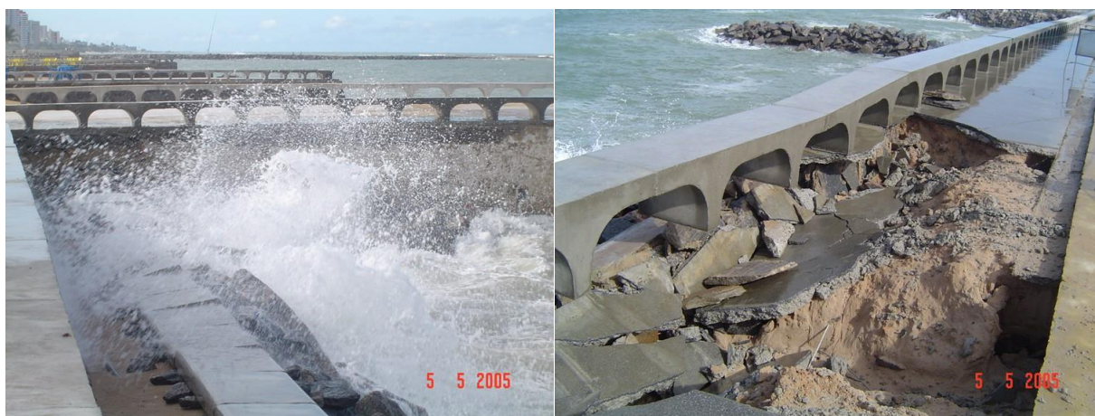
Figura 159 – Danos causados à urbanização pela sobrepassagem das ondas sobre o enrocamento.
