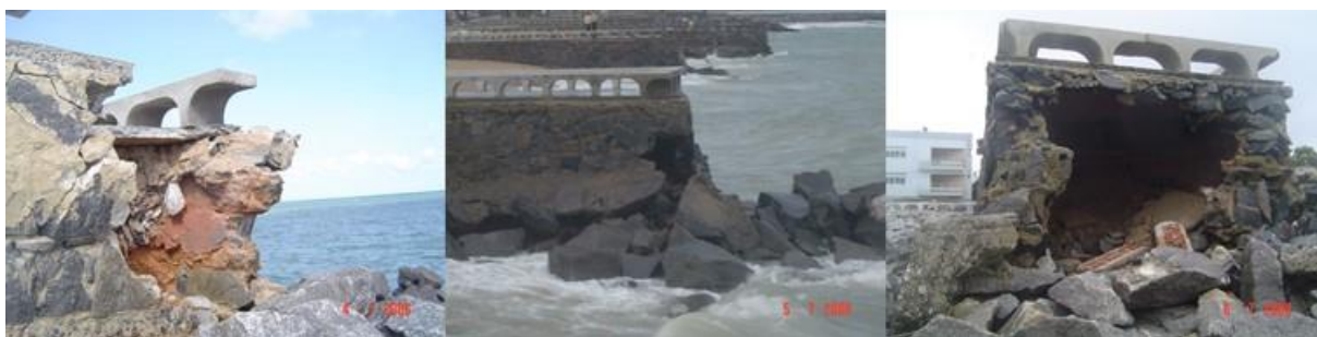
Figura 21 – Registros de desmoronamentos nos espigões da praia de Bairro Novo, Olinda-PE.
