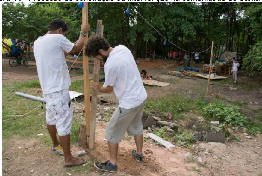
Figura 44 - Processo de construção da intervenção na comunidade de Santa Luzia
