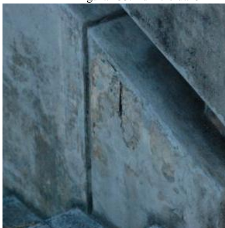
Figura 232: Edifício da CELPE. Destacamento do concreto. Figura 233: Edifício da CELPE. Corrosão com destacamento de concreto – brise.
