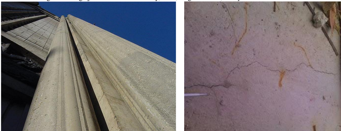
Figura 146: Igreja Notre Dame du Raincy, 1924, Auguste Perret, França. Superfície em concreto aparente. Figura 147: Igreja Notre Dame du Raincy, 1924, Auguste Perret, França. Processo deteriorativo.
