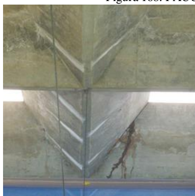
Figura 168: FAUUSP. Esquema de construção de viga com caixão perdido.
