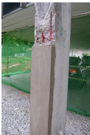
Figura 257: Pilar de fachada. Finalização do reparo, uso de esponja.
