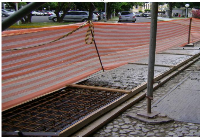
Figura 261: Construção de novo brise. Concretagem in loco.
