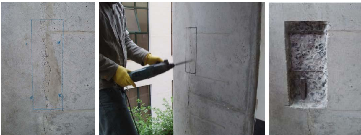
Figura 190 a 192: Intervenção proposta para o edifício da FAUUSP. Imagens de referência. Marcação e escarificação da estrutura deteriorada.
