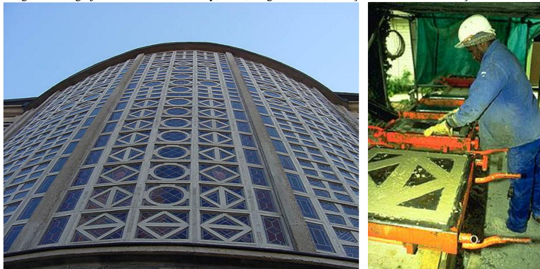
Figura 141: Igreja Notre Dame du Raincy, 1924, Auguste Perret, França. Processo de confecção dos elementos vazados
