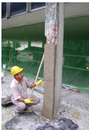
Figura 257: Pilar de fachada. Finalização do reparo, uso de esponja.
