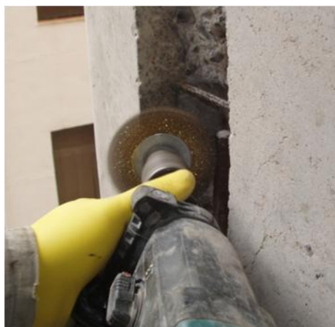
Figura 193: Intervenção proposta para o edifício da FAUUSP. Imagens de referência. Lixamento da armadura deteriorada. Figura 194: Intervenção proposta para o edifício da FAUUSP. Imagens de referência. Esquema explicativo de recomposição de armadura.
