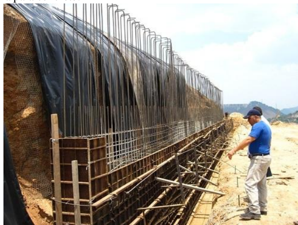
Figura 65: Armadura para concreto.
