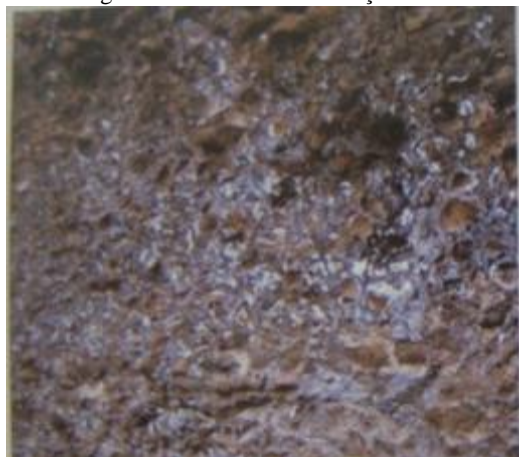
Figura 02: Concreto de fundação circular do Templo C em Roma, com placas de turfa como fôrma
