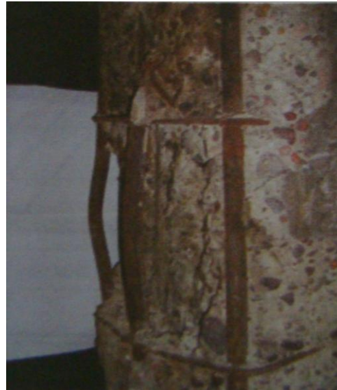
Figuras 79: Alterações na aderência entre o aço e a pasta do concreto atingido pelo fogo. Figuras 80: Alterações na estrutura de concreto atingida pelo fogo.
