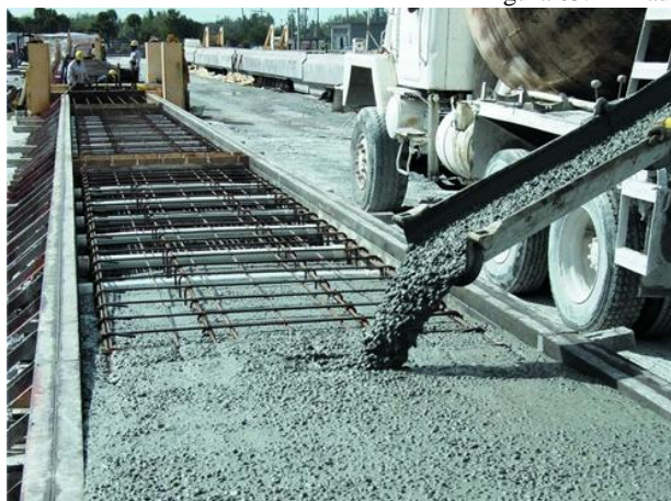
Figura 65: Armadura para concreto.
