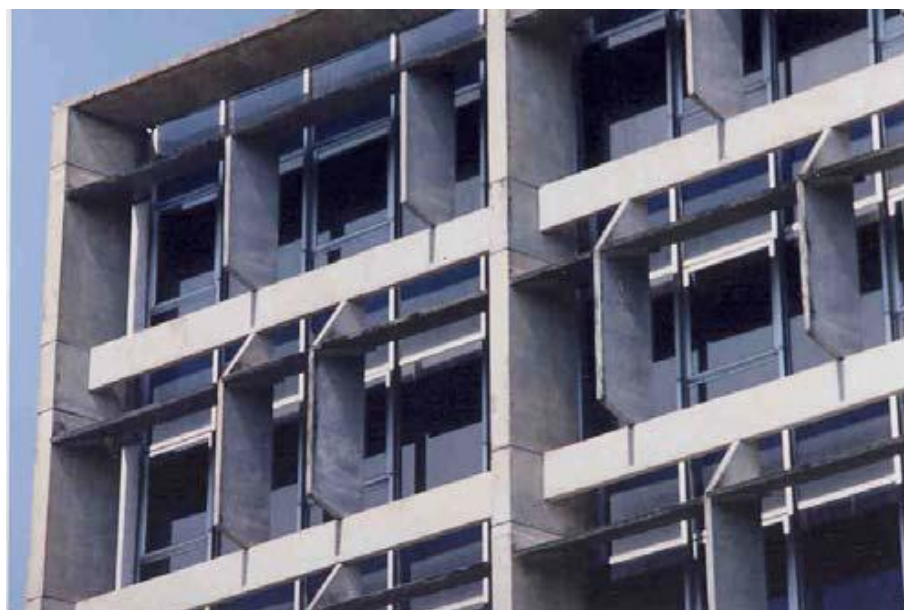
Figura 218: Detalhe da fachada frontal da CELPE. Brises verticais e horizontais.
