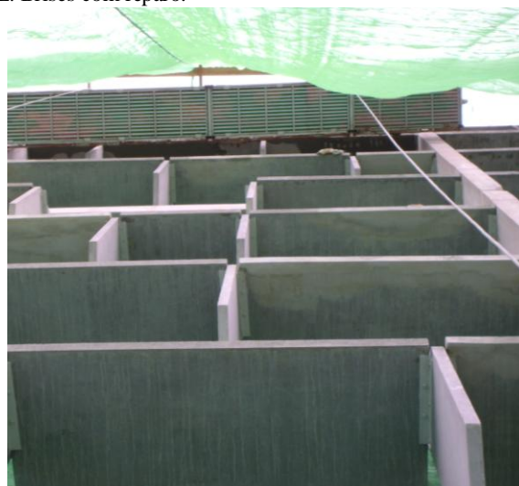
Figura 263: Edifício da CELPE. Brises com reparo.
