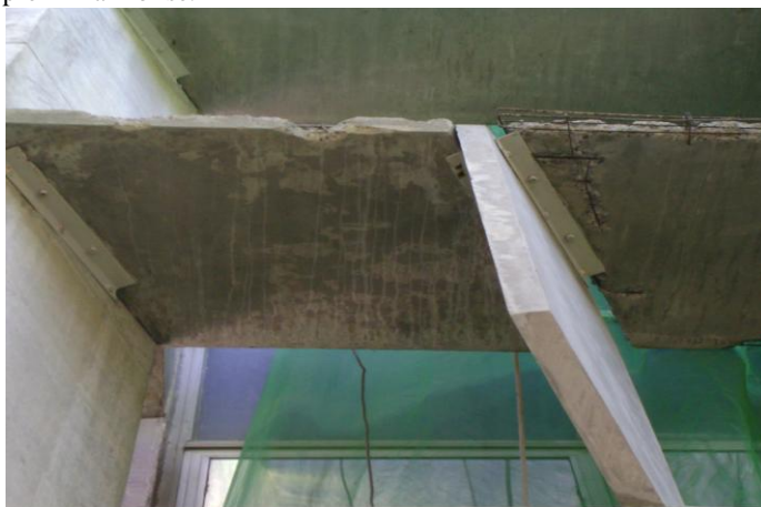
Figura 248 : Detalhe da fachada frontal do edifício da CELPE. Áreas passíveis de recuperação mapeadas na inspeção preliminar - brise.
