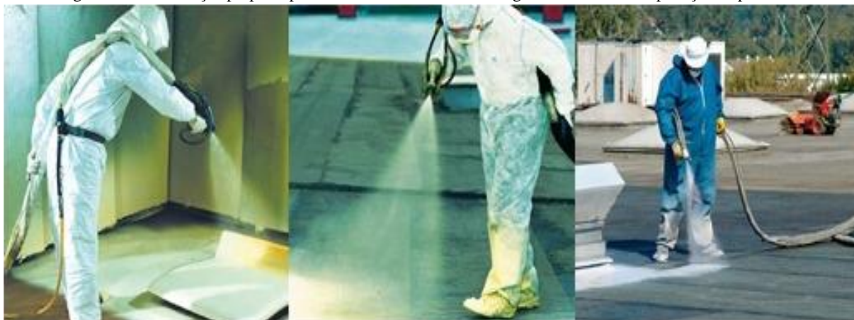
Figura 199: Intervenção proposta para o edifício da FAUUSP. Imagens de referência. Aplicação de poliuréia.
