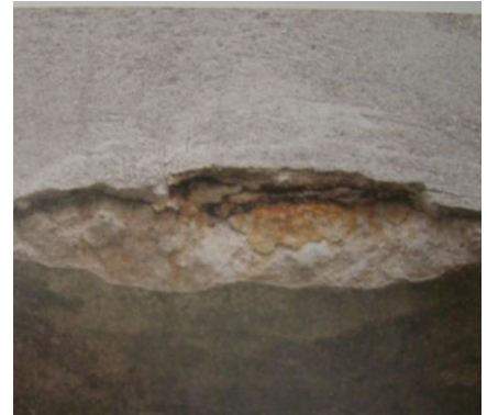
Figuras 81-83: Corrosão de armadura provocada pela presença de cloretos e destacamento da pasta. Pavilhão de Tênis da Quinta da Conceição, 1957, Fernando Távora, Leça da Palmeira, Porto, Portugal.
