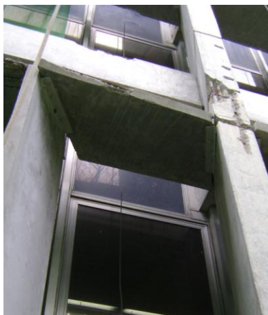
Figura 248 : Detalhe da fachada frontal do edifício da CELPE. Áreas passíveis de recuperação mapeadas na inspeção preliminar - brise.
