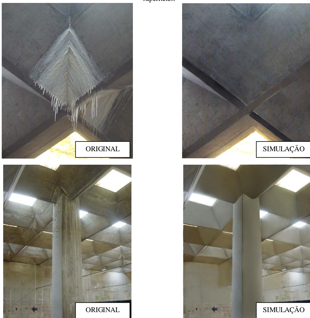
Figuras 205-208: Edifício Vilanova Artigas. Interior do edifício - superfícies em concreto aparente. Simulação da limpeza das superfícies.
