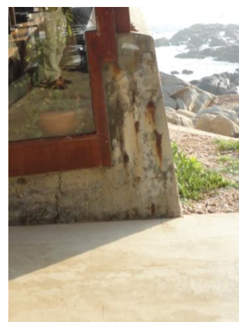
Figuras 85-87 : Corrosão de armadura com destacamento da pasta cimentícia. Casa de Chá da Boa Nova, 1963, Alvaro Siza, Leça da Palmeira, Porto, Portugal.
