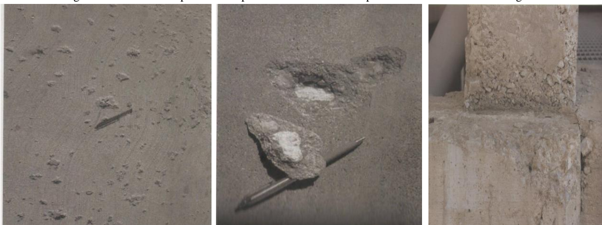
Figuras 94-96: Falhas superficiais na pasta cimentícia causadas por bolhas e ninhos de concretagem.
