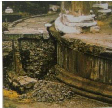
Figura 02: Concreto de fundação circular do Templo C em Roma, com placas de turfa como fôrma
