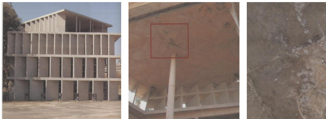
Figuras 91-93: Manchas de eflorescências causadas por lixiviação. Campidoglio de Chandigarh, 1962, Le Corbusier, Punjab, Índia.
