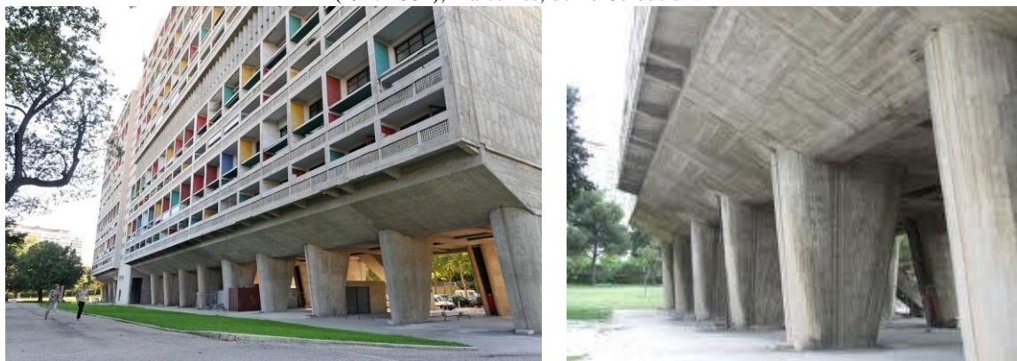
Figuras 111-112 : Texturas no concreto aparente criadas a partir de fôrmas de madeira, edifício Unité d'habitation (1947-1952), Marseilles, de Le Corbusier .
