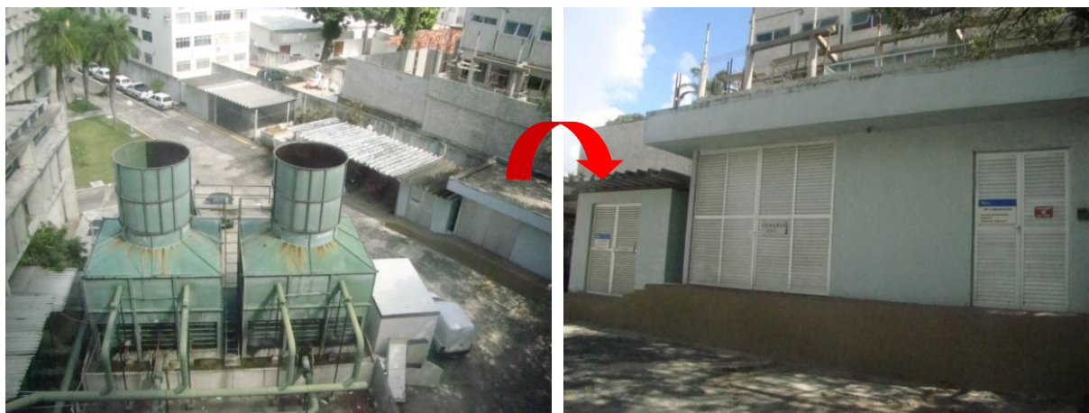
Figura 227: Torres de condensação colocadas no pátio interno da CELPE. Figura 228 Construção realizada para abrigar equipamentos como geradores, no pátio interno da CELPE.
