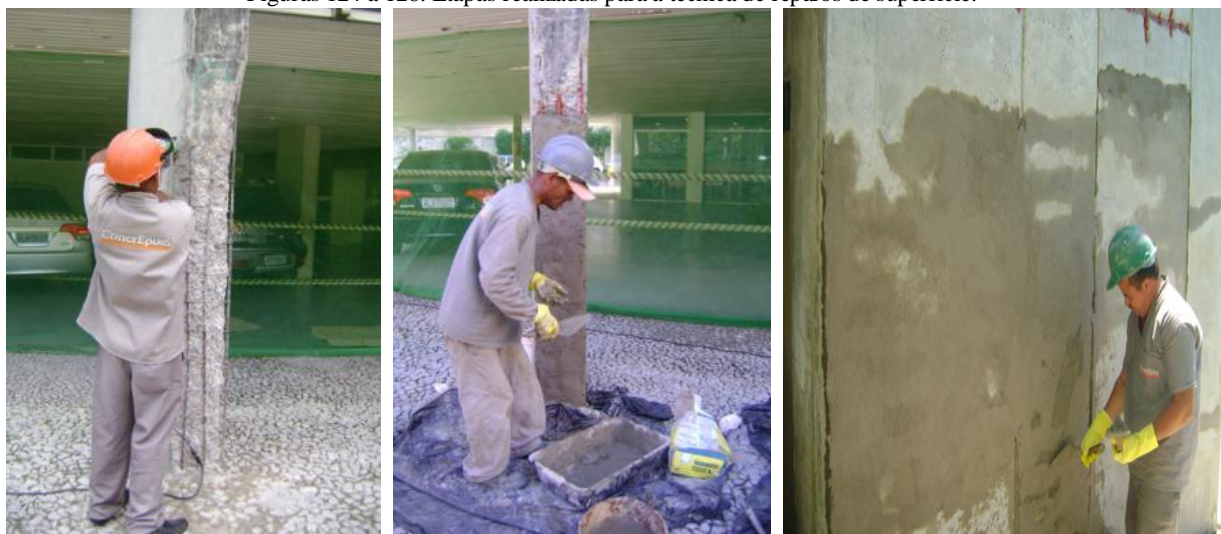
Figuras 124 a 126: Etapas realizadas para a técnica de reparos de superfície.
