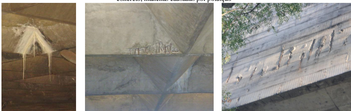
Figura 202 a 204: Danos que acometem o edifício da FAUUSP. Eflorescência, corrosão de armaduras e destacamento do concreto, manchas causadas por poluição
