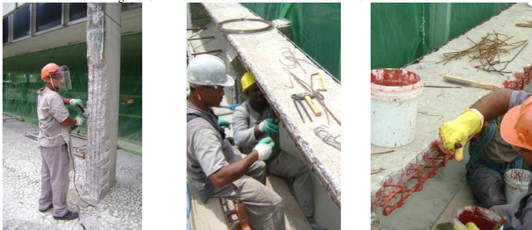
Figura 254: Brise horizontal. Pintura da armadura com tinta anticorrosiva.
