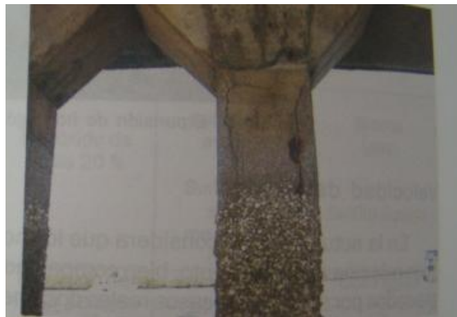
Figura 74: Concreto atacado por sulfatos presente na água do mar.
