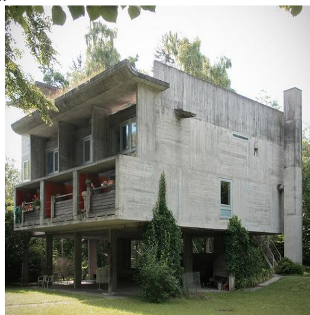
Figura 47: Casa Hesterberg, Atelier 5, 1960-1961, Flamatt, Suíça. Superfície de concreto aparente marcado pelas formas.
