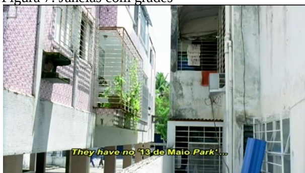
Figura 7: Janelas com grades
