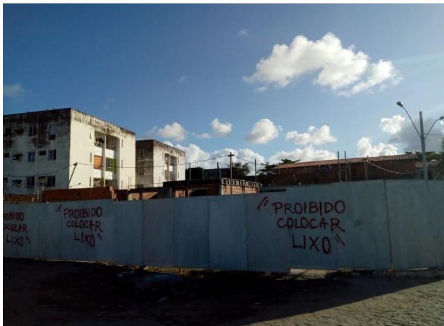
Imagem 27 - Canteiro de obras do Habitacional Deputado Guilherme Uchoa
