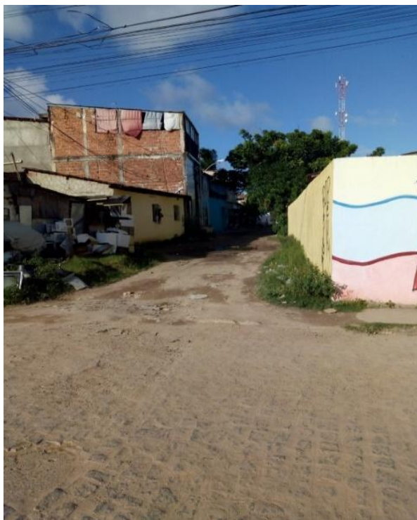
Imagem 25 - Rua sem asfalto na área da UE-23
