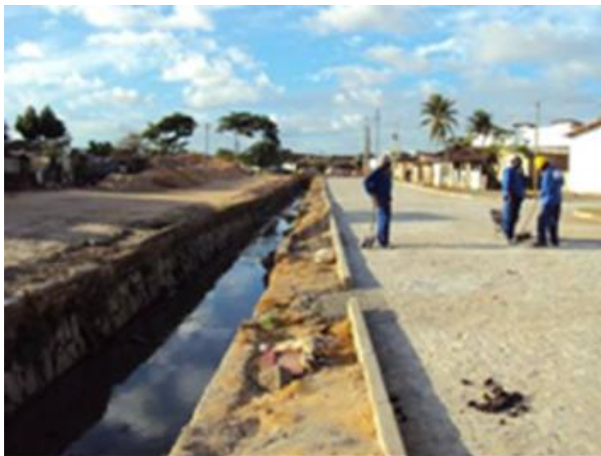
Imagem 12 - Obras do Canal Farias Neves
