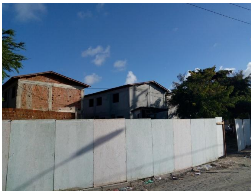
Imagem 28 - Frente do Habitacional em construção
