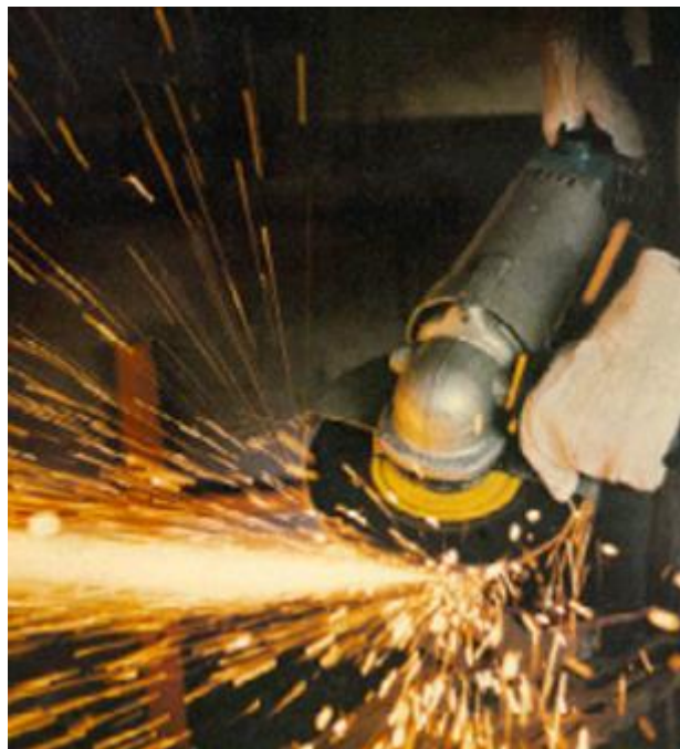
Figura 15- Esmerilhamento do ressalto da solda.
