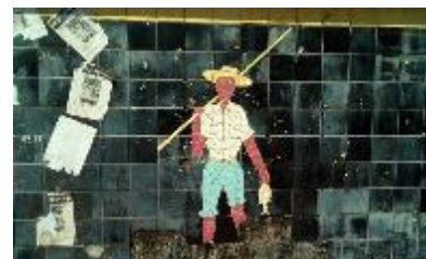
Figura 66 – Espaço deixado pelas peças de azulejo faltantes escurecido e papéis colados no painel da Praça Jorge de Lima (16).
