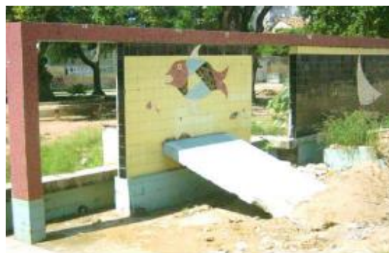
Figura 63 – Marquise da fonte da Praça Jorge de Lima (16) caída sobre espelho d'água.
