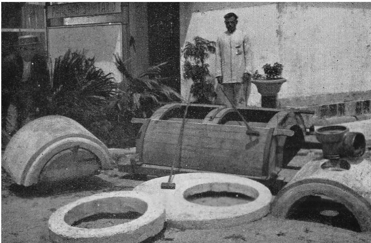
**Imagem 7** - Formas para coletores em concreto<sup>327</sup>.
