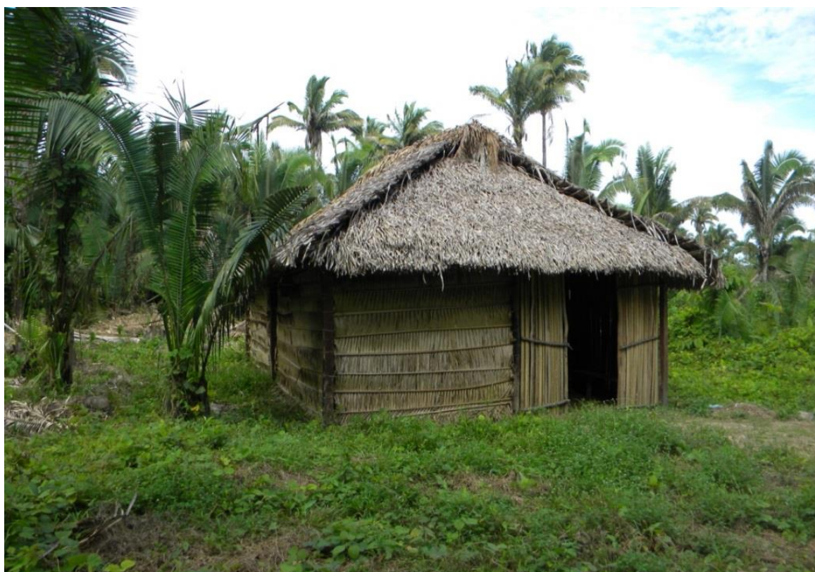
Fotografia 27 – Casa construída utilizando como matéria-prima as folhas da palmeira babaçu
