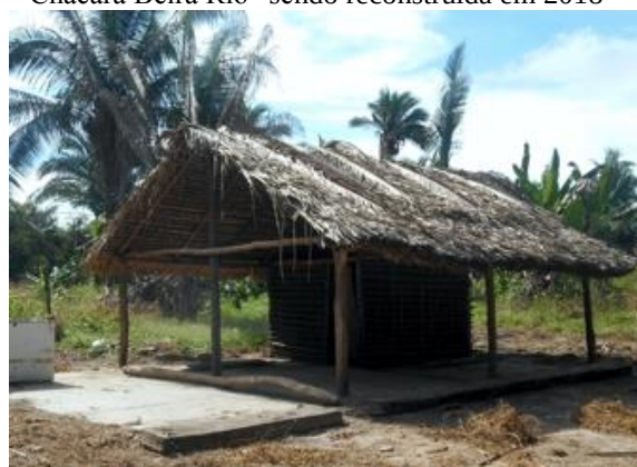
Fotografia 54 – Casa onde havia a identificação “Chácara Beira Rio” sendo reconstruída em 2018
