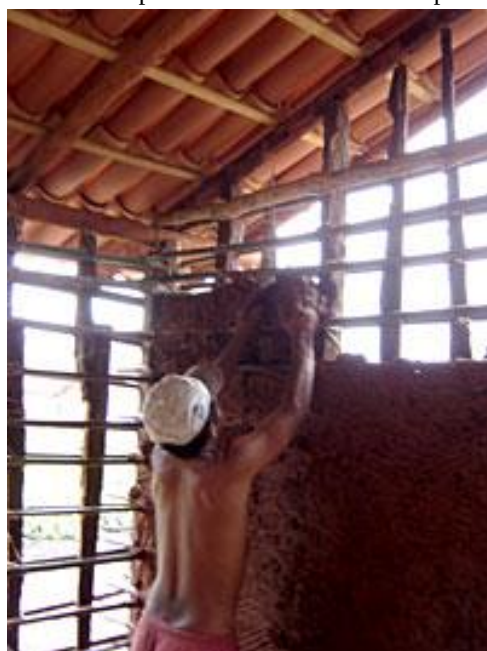
Fotografia 28 – Estirpe da palmeira babaçu servindo para estrutura de casa de taipa
