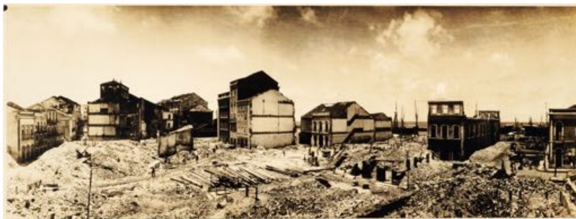
Imagem 06 – Demolição da Rua do Bom Jesus, Recife. Francisco du Bocage, 1913.
