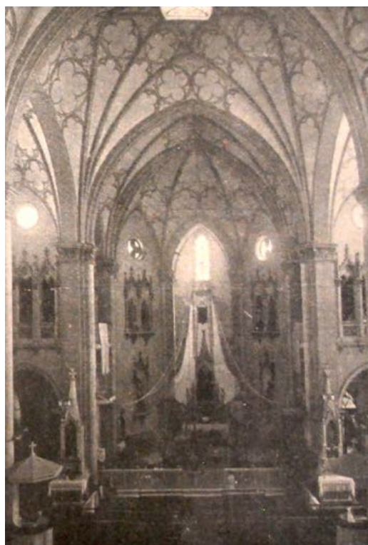
Imagem 26 – Nave Principal da Catedral de Nossa Senhora da Luz, Curitiba, Paraná.
