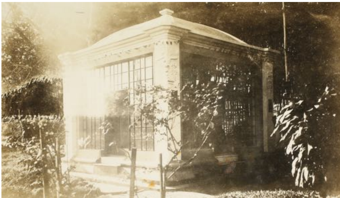
Imagem 58 – Barraca onde Euclides da Cunha escreveu Os Sertões já protegida pelo abrigo construído em 1928, São José do Rio Pardo, São Paulo. Autor não identificado, Sem data.
