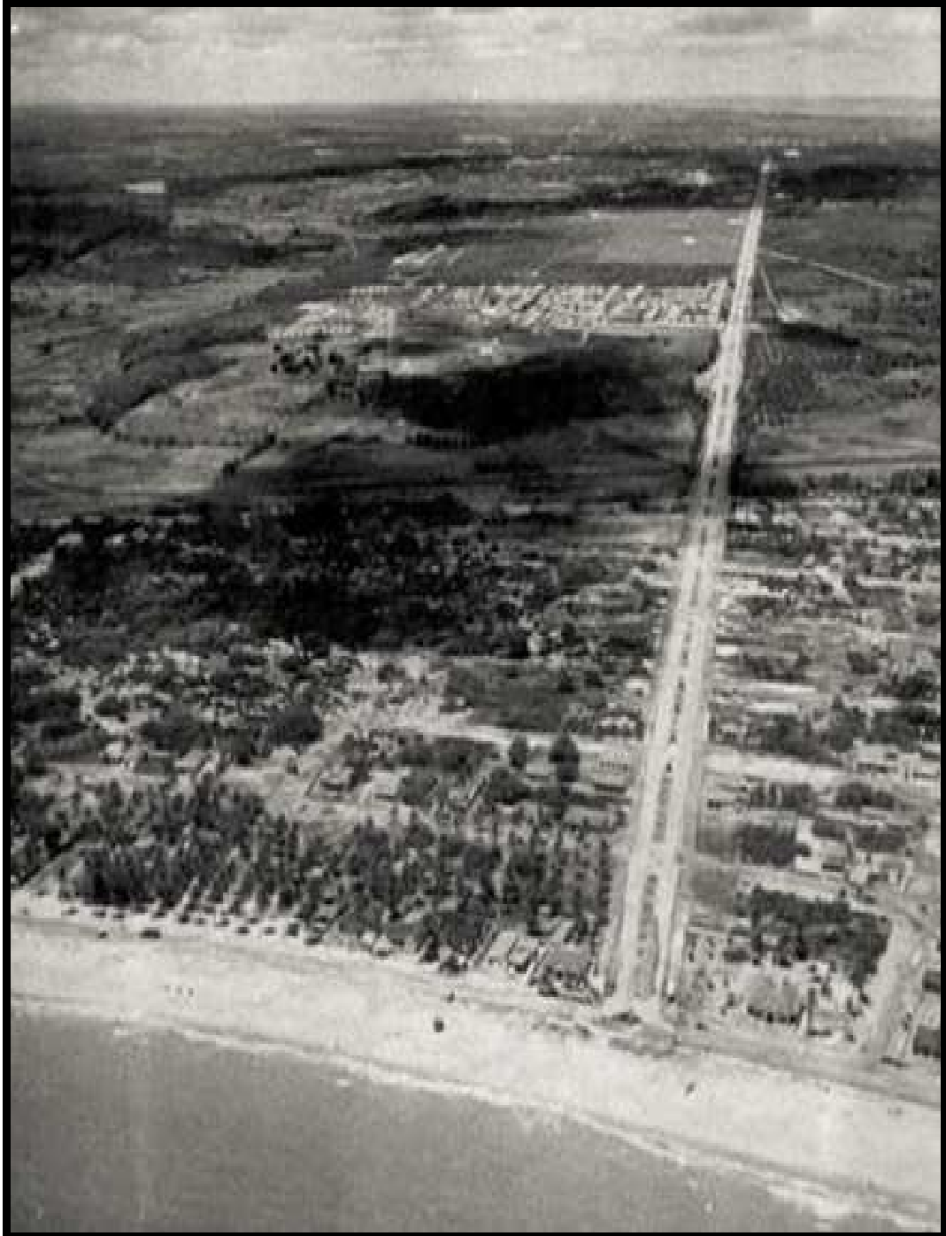
Figura 10 - Foto aérea da Avenida Epitácio Pessoa.
