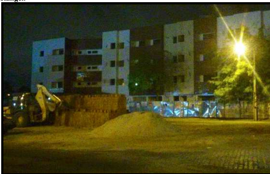
Figura 58 - Visão, desde a Rua 02 de Fevereiro, da construção do Residencial Príncipe do Rangel.
