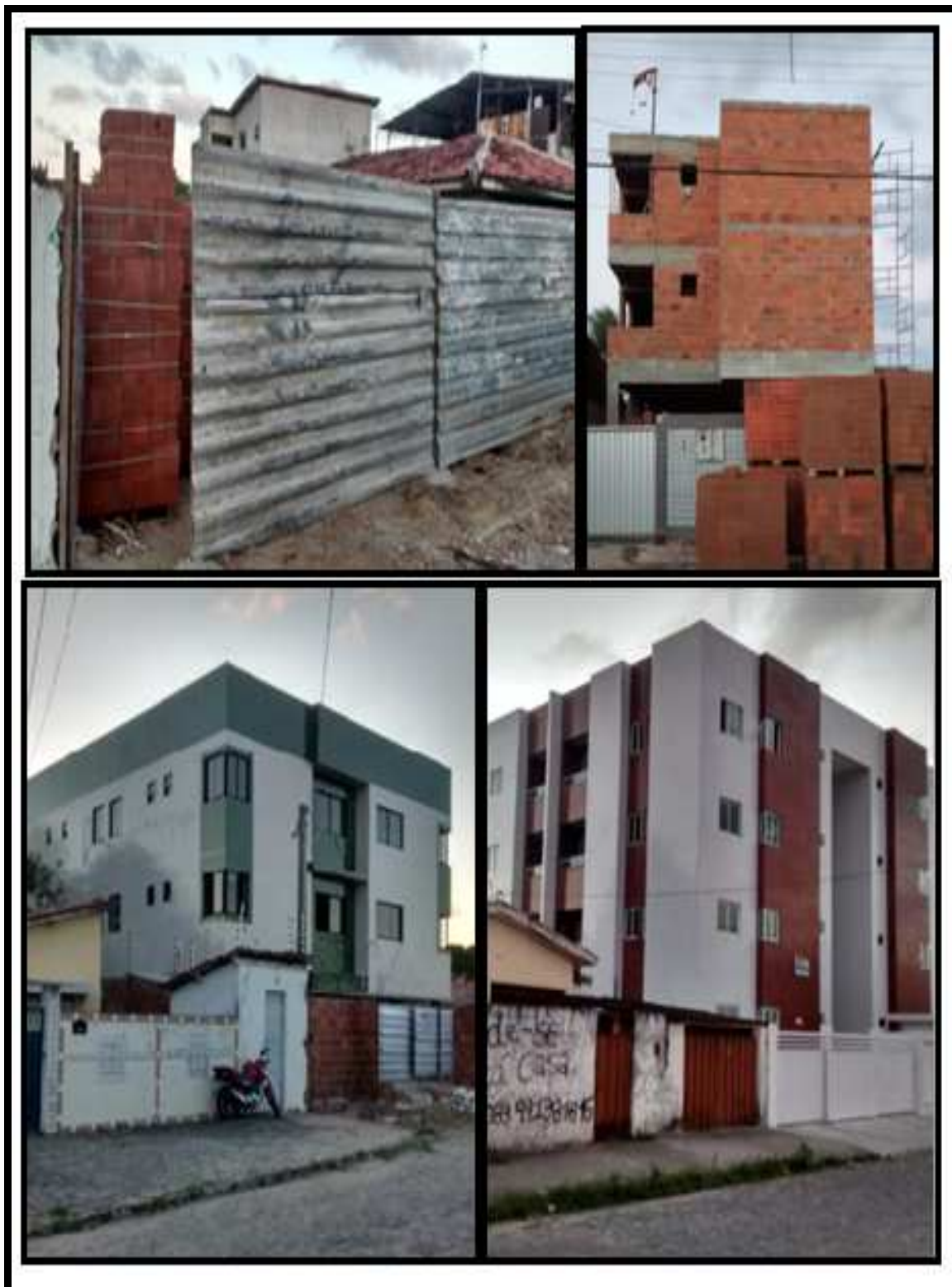
Figura 59 – Edifícios construídos e em construção, na Rua Rangel Travassos e na Rua Mourão Rangel, no processo de verticalização das moradias no Varjão/Rangel.
