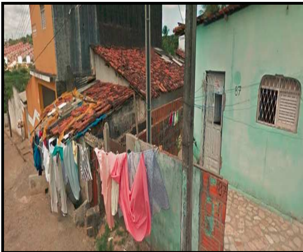
Figura 18 – Visão em perspectiva de casas populares e do uso doméstico da rua e da vizinhança, na Rua Bom Jesus. Em segundo plano, na parte superior esquerda da imagem, aparece a Comunidade Paulo Afonso II.
