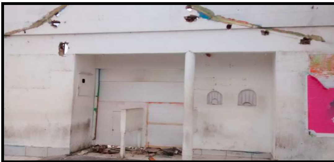
Figura 61 – Imagem da fachada do CAC do Rangel em processo de demolição.
