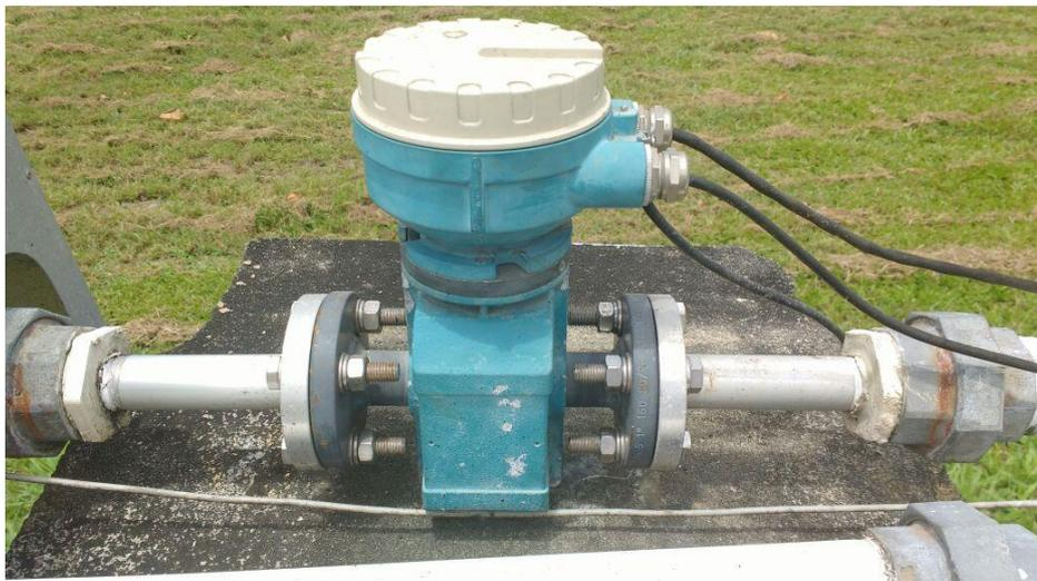
Figura 32 (continuação): Medidor de vazão eletromagnético
