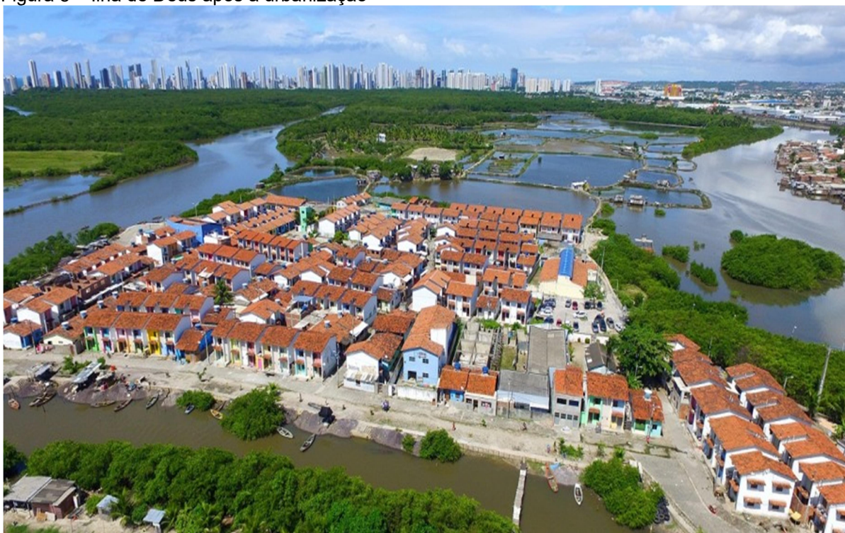
Figura 8 – Ilha de Deus após a urbanização
