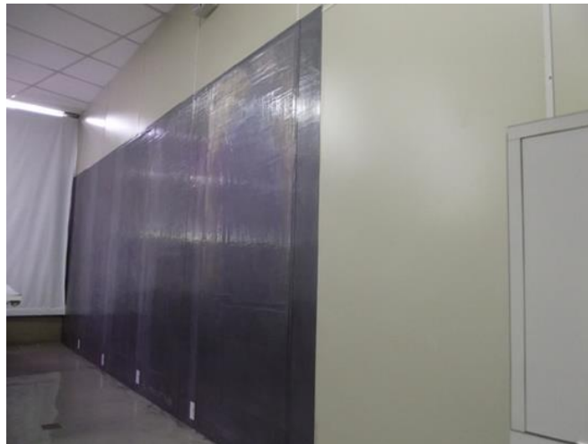
Figura 5 – Montagem física de sala de radiodiagnóstico com folhas de Chumbo.
