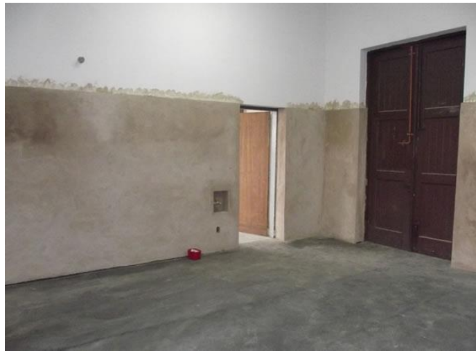
Figura 6 – Construção de sala de raios X com argamassa de barita.
