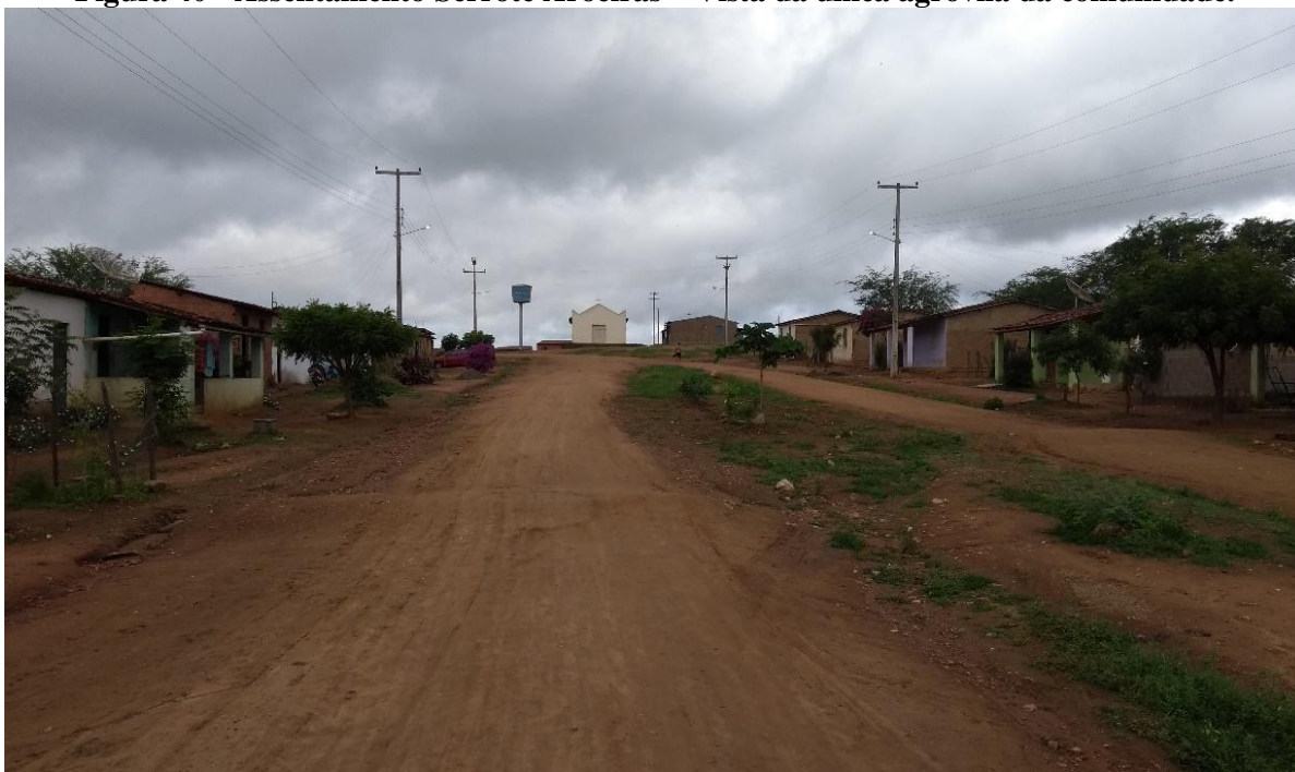
Figura 40 - Assentamento Serrote Aroeiras – Vista da única agrovila da comunidade.
