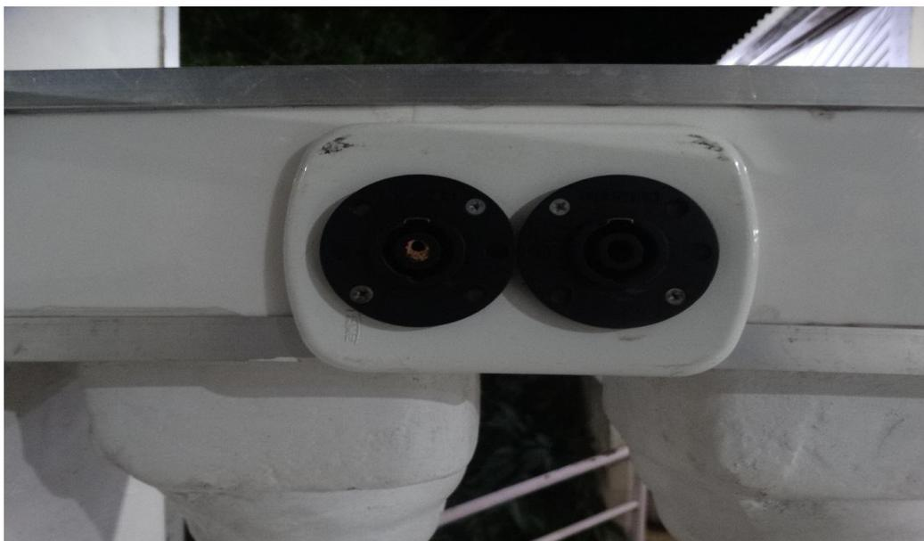
Figura 9 O Sistema de cabeamento da CEOCPE é pensado de forma arquitetônica. A importância dada a música foi pensada de forma arquitetonicamente estrutural dentro da religião. Na foto temos tomadas de entrada e saída de cabos que se conectam a instrumentos e a mesa de som FOTO: Luiz Augusto Moura
