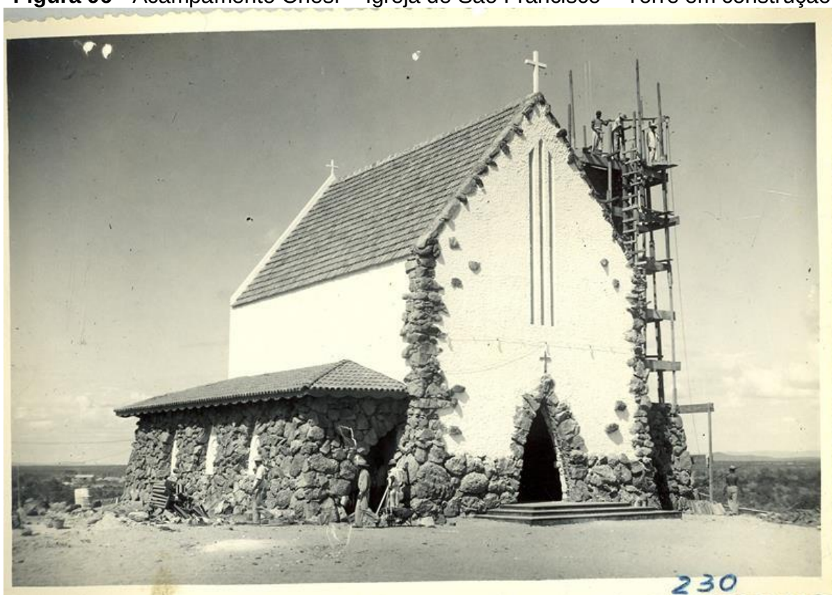
Figura 96 - Acampamento Chesf – Igreja de São Francisco – Torre em construção
