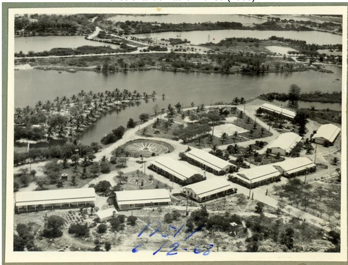
Figura 26 – Vista aérea do conjunto de pavilhões do Centro de Formação Profissional de Paulo Afonso (1968)
