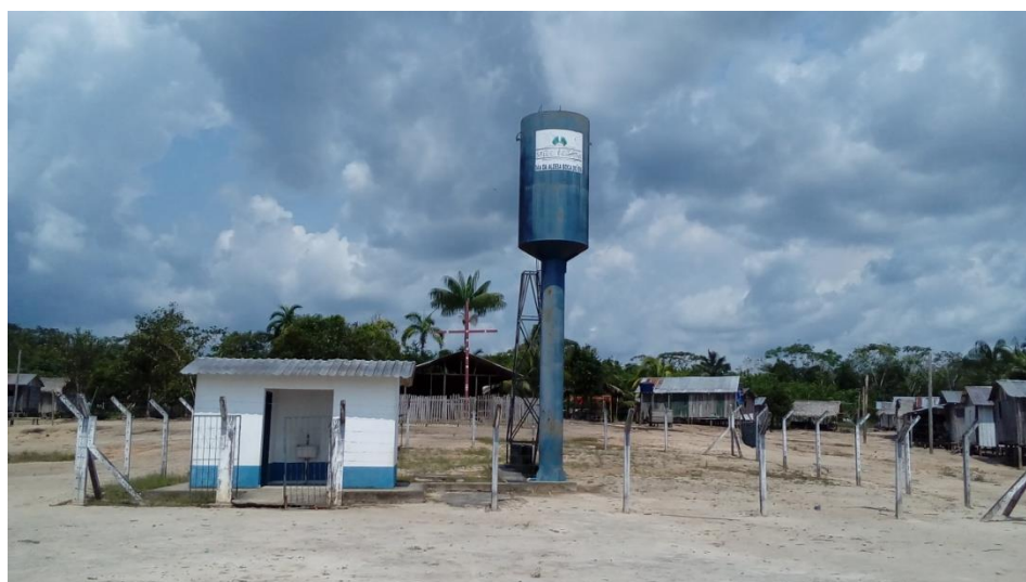
Figura 6 - Casa de máquinas do poço artesiano.
