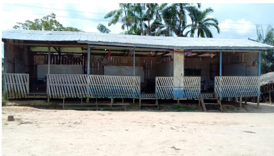
Figura 4 - Escola com três salas de aula.
